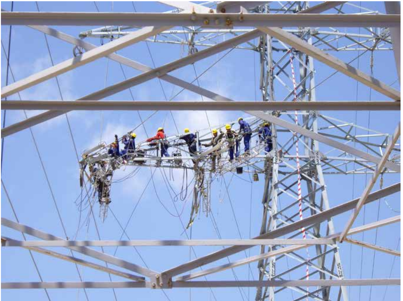
Trabajos en líneas de distribución
