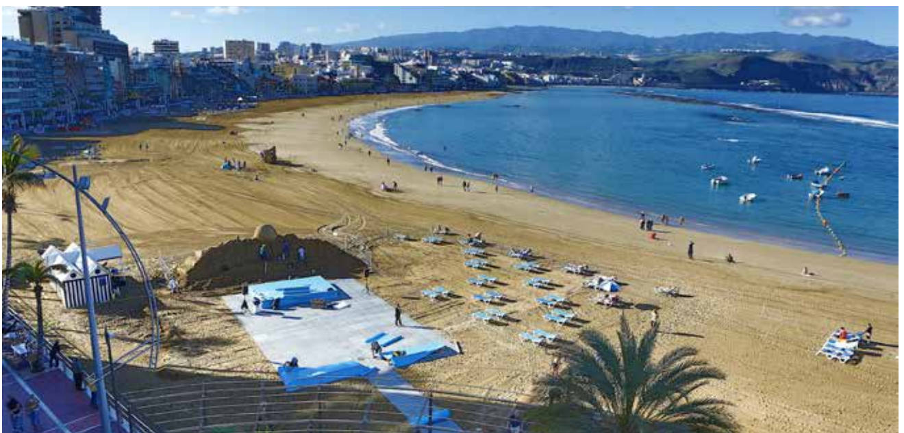
Montaje de infraestructuras para la Copa Fan Zone-Minicopa ENDESA en Las Palmas de Gran Canaria
