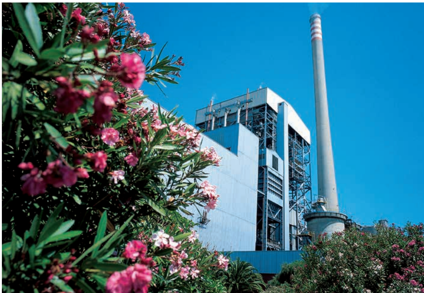
Central térmica de ciclo combinado Cristobal Colón (Huelva)
