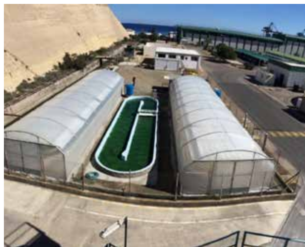
Planta piloto de microalgas en la Central Térmica Litoral de Almería.
