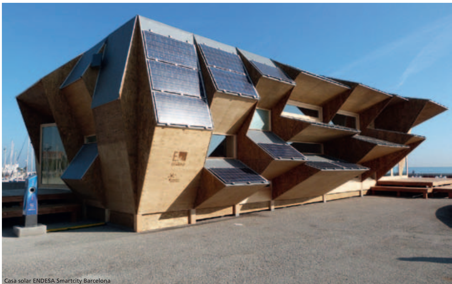
Casa solar ENDESA Smartcity Barcelona
