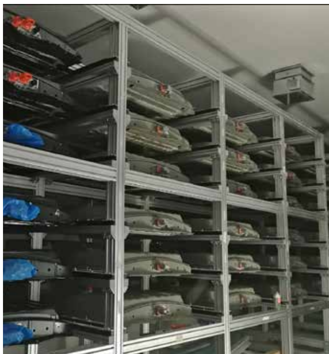
Proyecto self: Construcción de la planta de demostración de baterías de segunda vida de vehículos eléctricos
