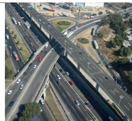
■ ■ ■ Viaducto Bicentenario. México.
