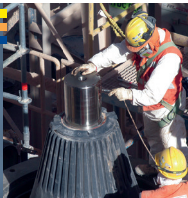
■ Empleados de OHL Industrial Chile realizan trabajos en la planta de chancado de riolita de Minera Escondida.
