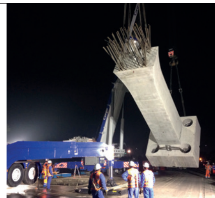
■ ■ ■ Obras de construcción de la autopista Libramiento Elevado de Puebla, en México.
