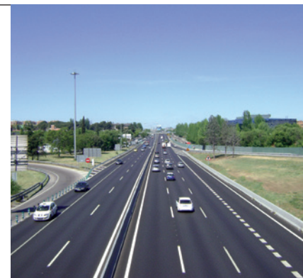
■ ■ ■ Tramo de la Autovía A-2 en la Comunidad de Madrid.
