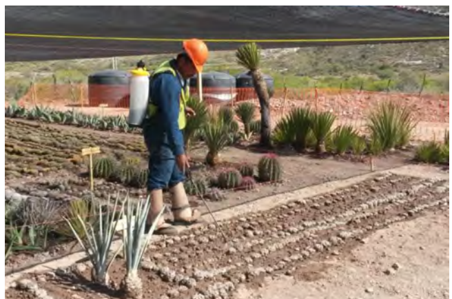
Gaseoducto Los Ramones Fase II Norte. México. Mantenimiento y cuidados de los organismos rescatados en el vivero temporal.
