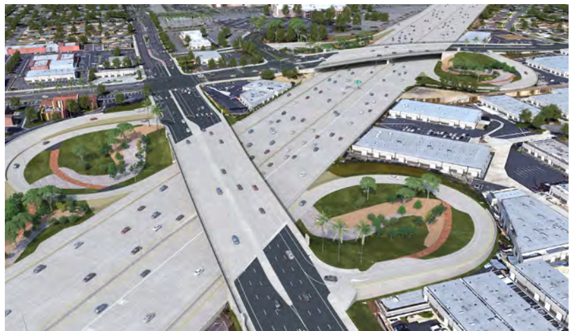
Mejora de la Autopista I-405 en California. EEUU.
