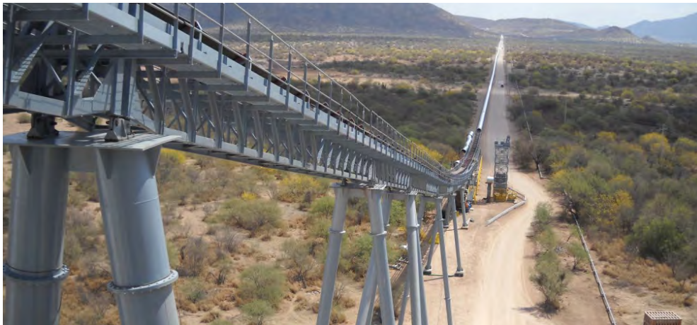
Vista general del Transportador curvo de 4,5 Km en Hermosillo. México.
