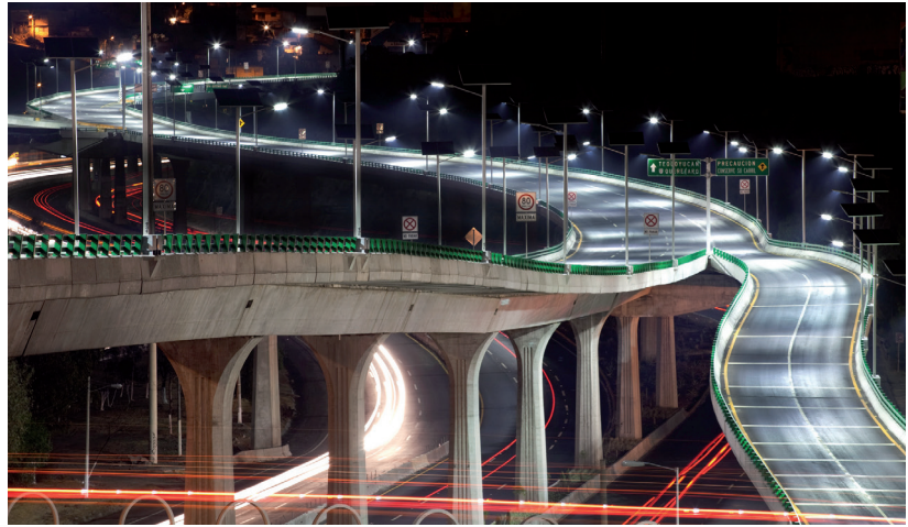
Autopista Viaducto Bicentenario. México.
