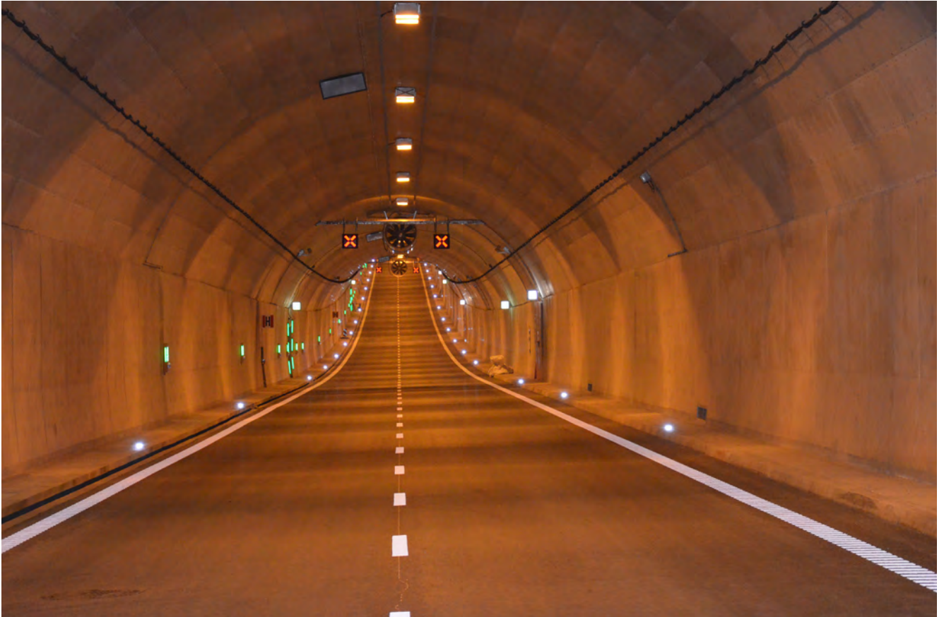
Doble túnel bajo el río Vístula. Polonia.
