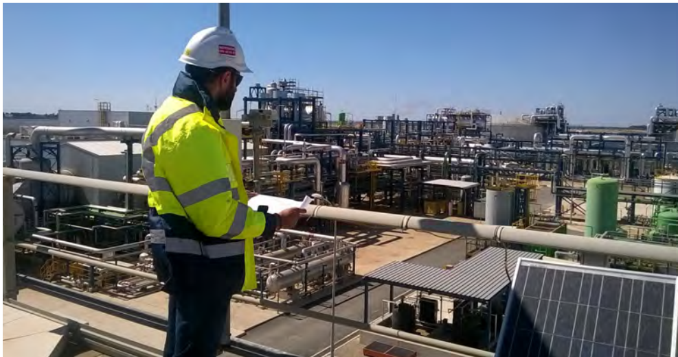
Operación y mantenimiento. Planta termosolar de Arenales. Morón de la Frontera. España.
