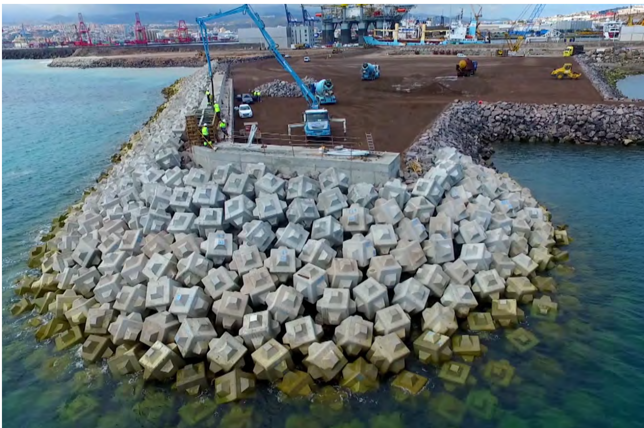
Manto de Cubipods en Puerto de A Coruña. España.
