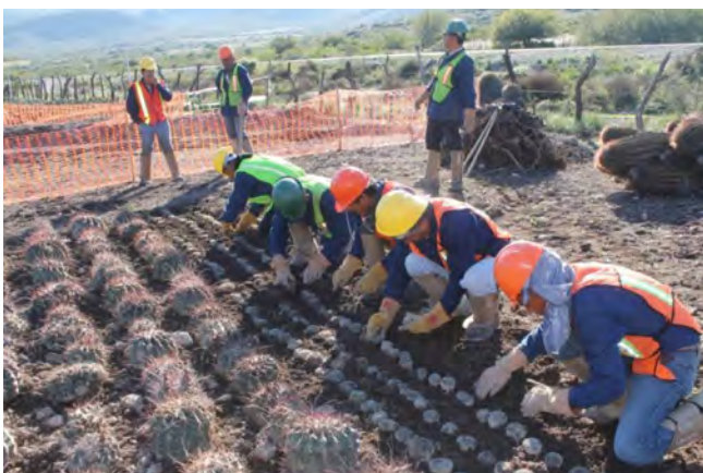
Gaseoducto Los Ramones Fase II Norte. México. Preparación y sembrado de los organismos rescatados.
