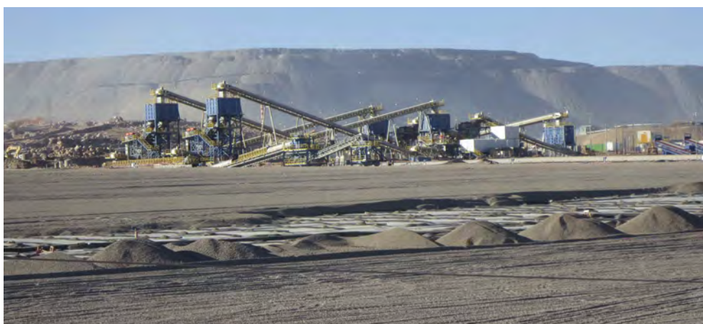
Planta de tratamiento de cobre. Chile.
