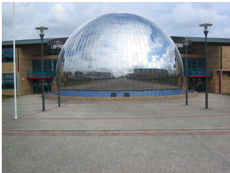
Amphithéâtre « Le Dôme », Arras, France © Pierre Rousse Aperam stainless steel used: Uginox Bright Nuance 304/1.430
