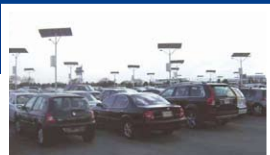
Panel solar en la Autopista Circunvalación de México, D.F. Durante 2007, entre las medidas aplicadas para gestionar de manera racional los recursos, OHL Concesiones ha sustituido en esta autopista 60 farolas por otras alimentadas por paneles solares, que se suman a las 77 ya sustituidas en 2006.
