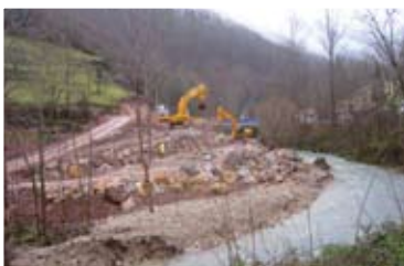
Protección de los cauces para evitar la afección a la vegetación de ribera y reducir el arrastre de sólidos al cauce. Obra: aparcamientos ecológicos de Covadonga (España).
