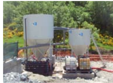
Gestión de sustancias peligrosas en obra para evitar derrames accidentales y controlar las posibles fugas. Plataforma de la Línea de Alta Velocidad León-Asturias, tramo La Robla-Túneles de Pajares.
