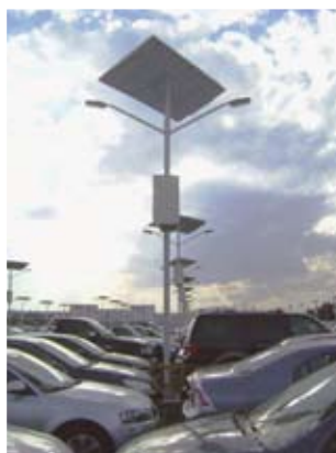
Farolas de alimentación solar en el Aeropuerto Internacional de Toluca.
