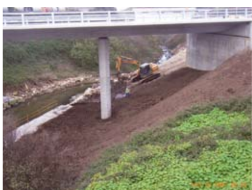
Obra UTE Langosteira. Restauración del viaducto con el aporte de 2.000 m 3 de tierra vegetal, sembrado manual de 200 kg de mezcla de herbáceas leguminosas (60%-40%) y una plantación en cepellón de 26 alisos negros ( Alnus glutinosa ) y 30 sauces ( Salix sp. ).
