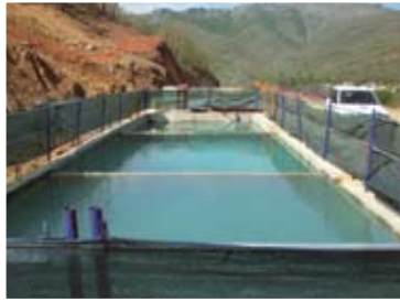
Obra de la plataforma de la Línea de Alta Velocidad León-Asturias, tramo La Robla-Túneles de Pajares. Imágenes antes y después del tratamiento de las aguas procedentes de refrigeración en la ejecución de un túnel.
