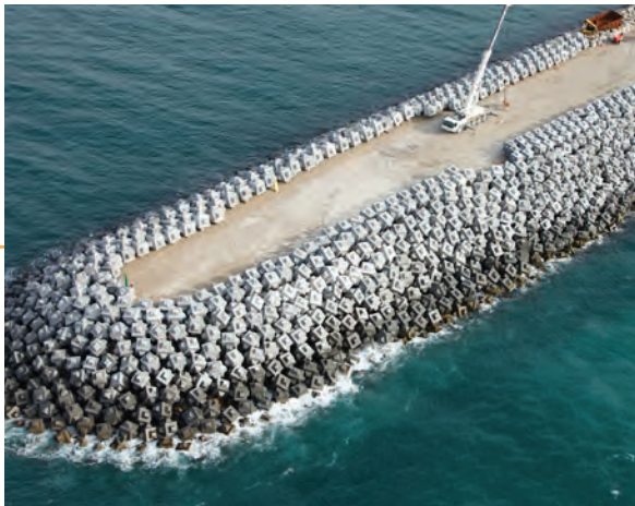
Empleo del cubípedo en la obra del contradique del puerto de Punta Langosteira, en A Coruña, España.
