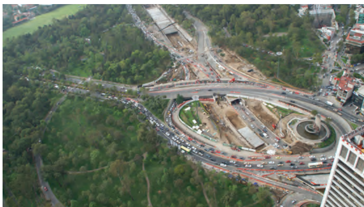
Construcción del tramo deprimido de la vía.
