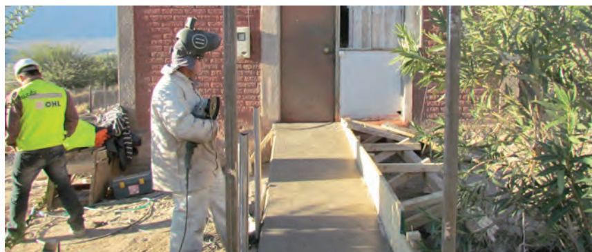
Construcción de una rampa de acceso para silla de ruedas.
