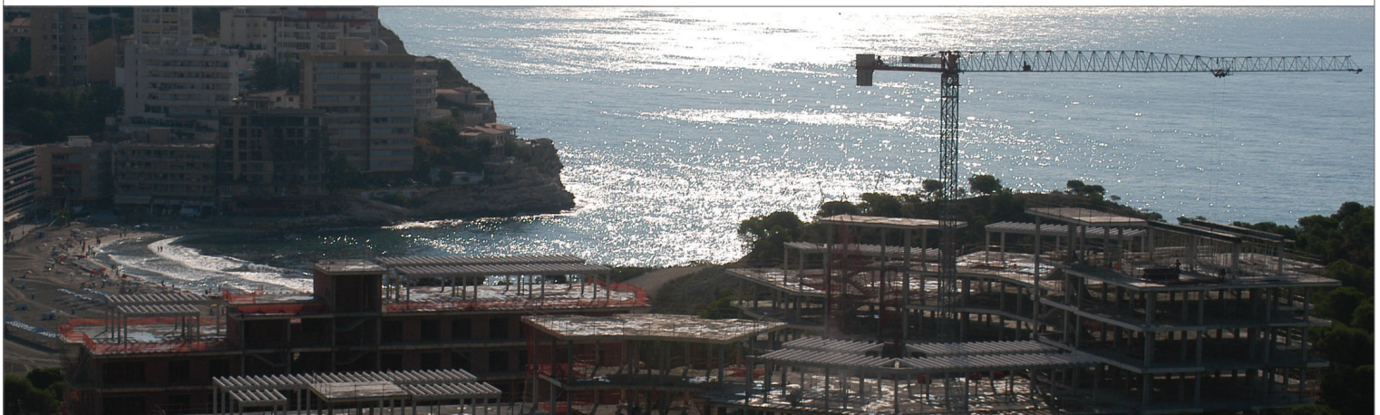
Obras de la Residencia de Villajoyosa, Alicante
