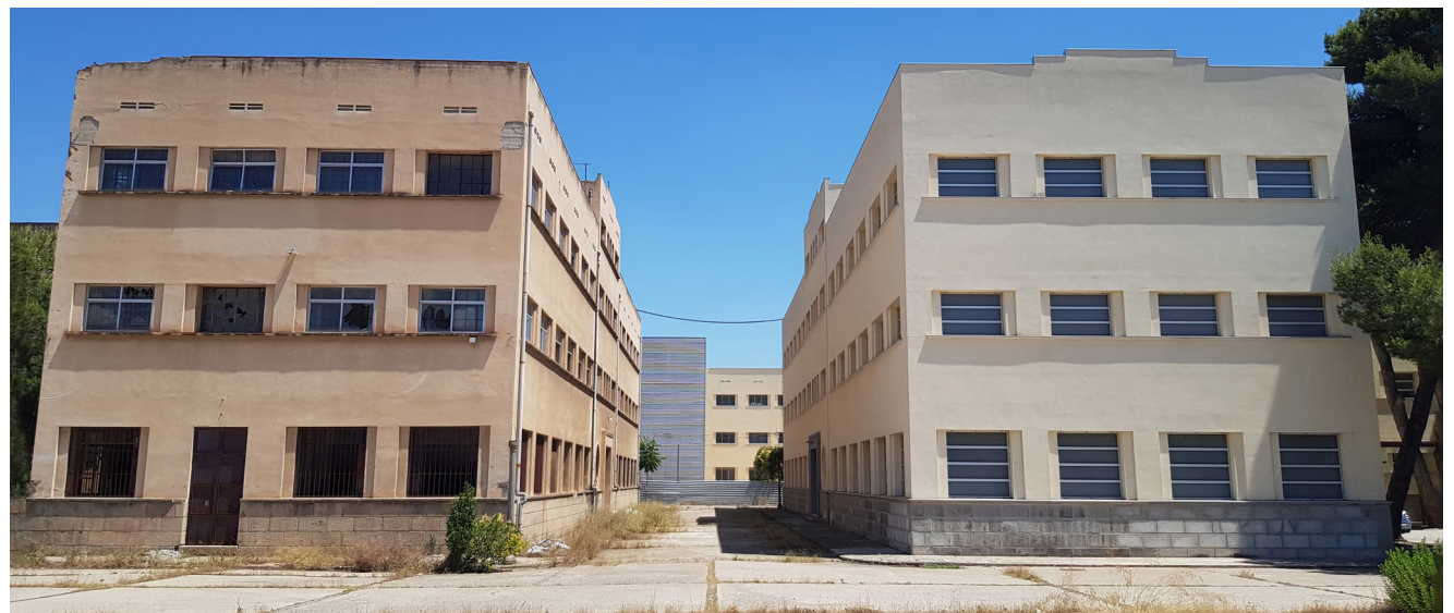
L'edifici de l'esquerra, el futur GEPA2, que caldrà rehabilitar.
