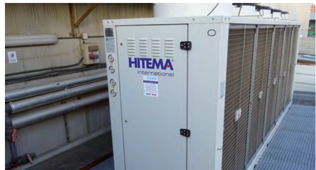
CEPEX - Incorporación de equipo de refrigeración free-cooling en Cepex Granollers.
