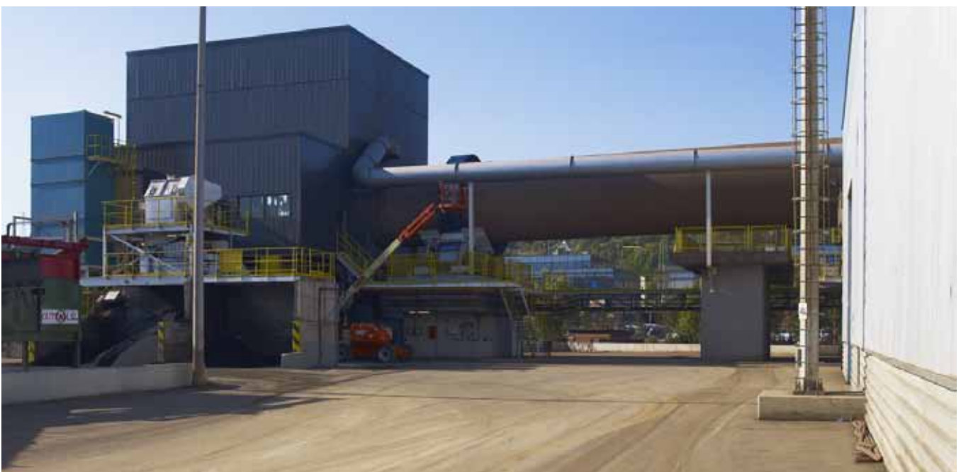
Vista lateral del horno Waelz de Befesa Zinc Aser, España
