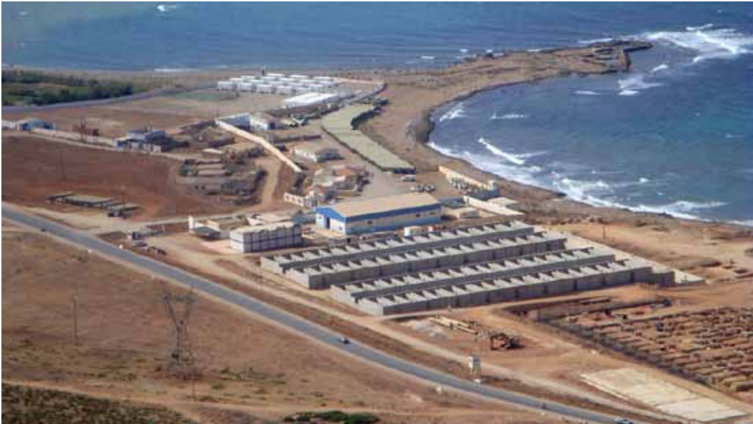
Vista de la obra de la desaladora de Tenes, Argelia
