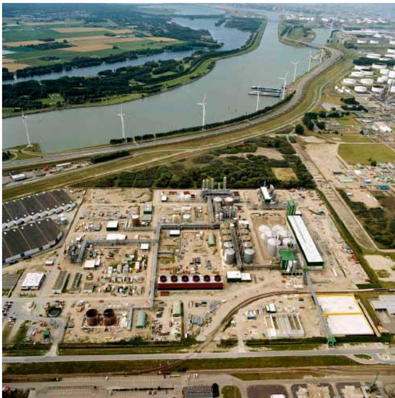
Planta Abengoa Bioenergía Netherlands de bioetanol ubicada en el puerto de Róterdam, Holanda, una de las más grandes del mundo
