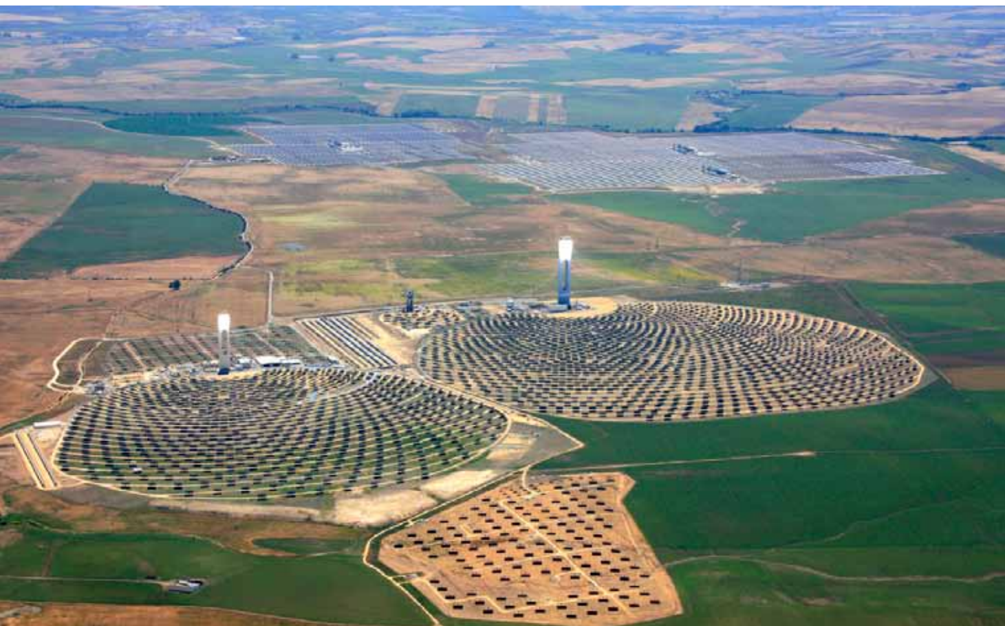
Vista aérea de la Plataforma Solúcar en Sevilla en junio del 2010
