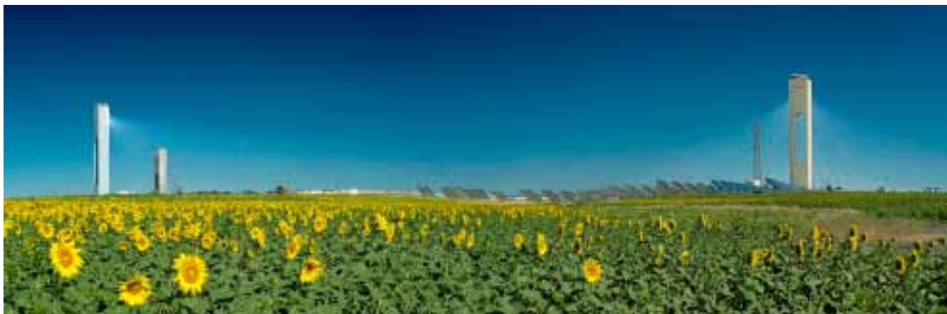
Vista de PS10 y PS20 operando junto a Eureka, planta de demostración de torre de alta temperatura
