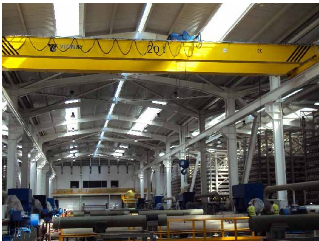
Interior de la obra de la desaladora de Honaine, Argelia
