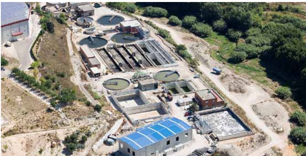
Vista de la obra de reutilización de Alcoy, España
