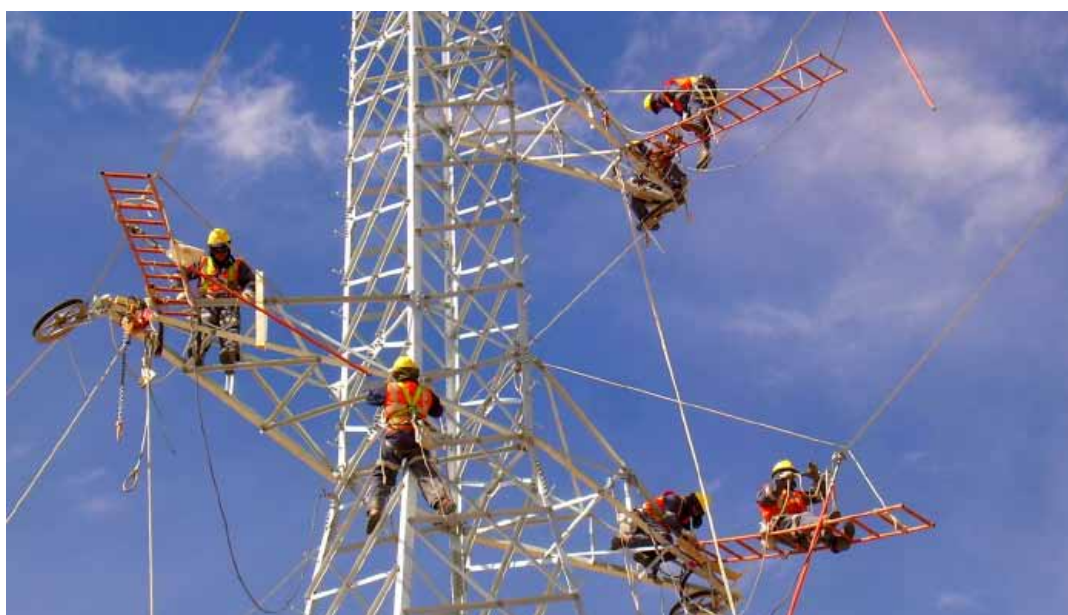
Trabajadores realizando maniobras de construcción en una torre de línea de transmisión en Chile
