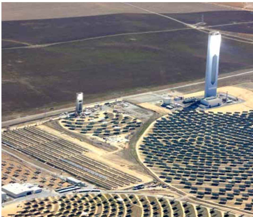
Vista aérea de la Plataforma Solúcar, en Sevilla, en la que se pueden apreciar algunas de las instalaciones de I+D
