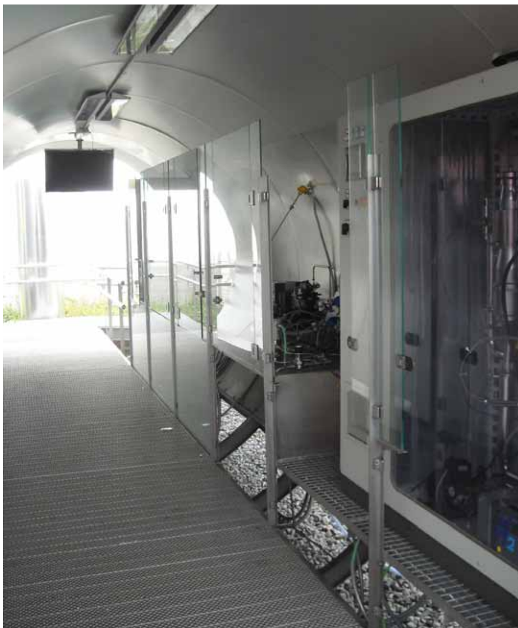
Sistema de producción de hidrógeno y pila de combustible para el Campus Palmas Altas
