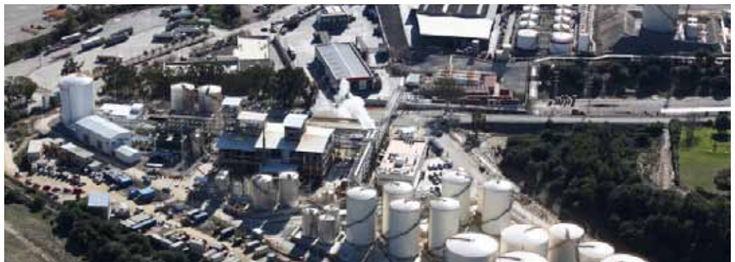
Planta de biodiésel en San Roque, Cádiz
