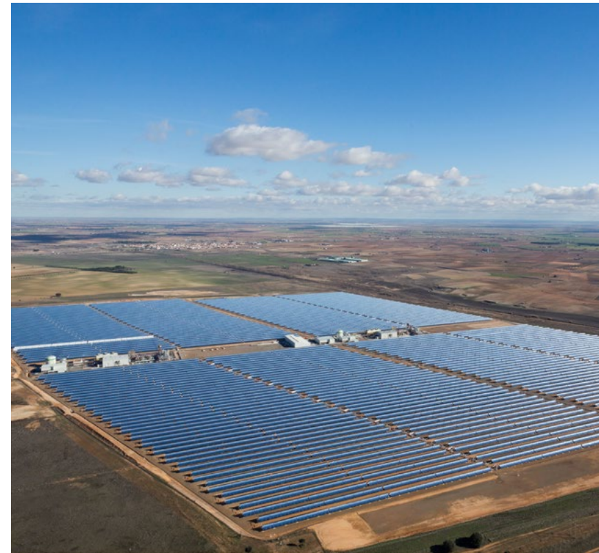
La Plataforma Solar Castilla-La Mancha cuenta con dos plantas cilindroparabólicas idénticas de 50 MW cada una, independientes en su construcción y funcionamiento.
