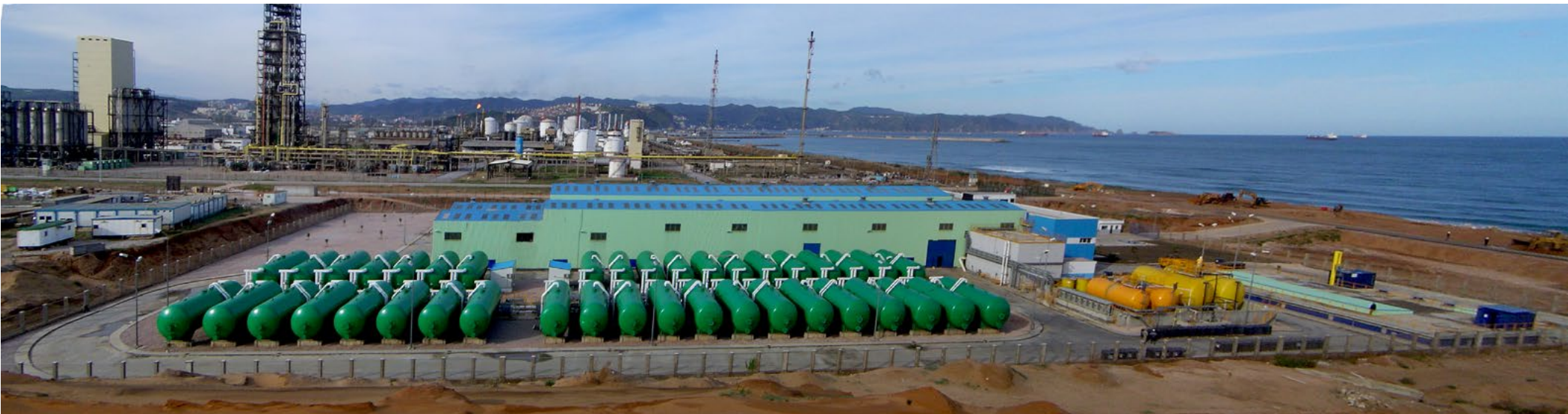
Planta desaladora de Skikda (Argelia), con una capacidad de 100.000 m 3 /día y en operación desde 2009
