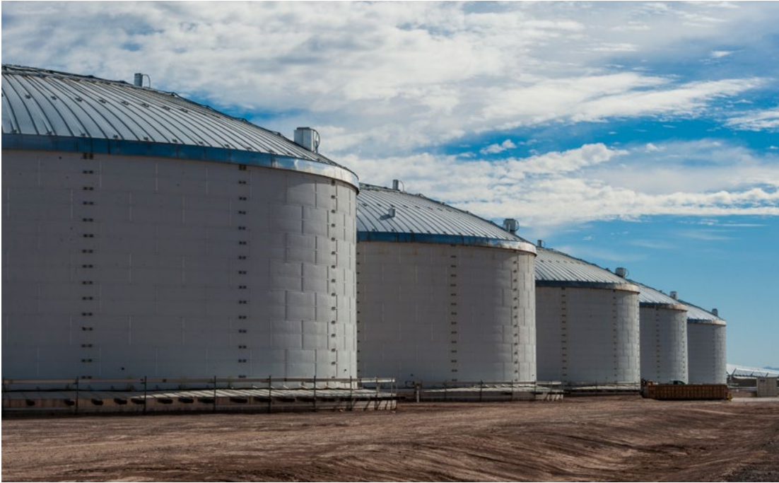
Almacenamiento térmico en tanques de sales fundidas
