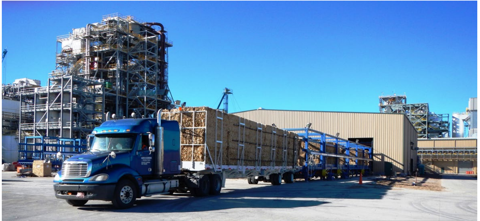
Descarga de cosecha en la planta de Hugoton (Kansas, EE. UU.)
