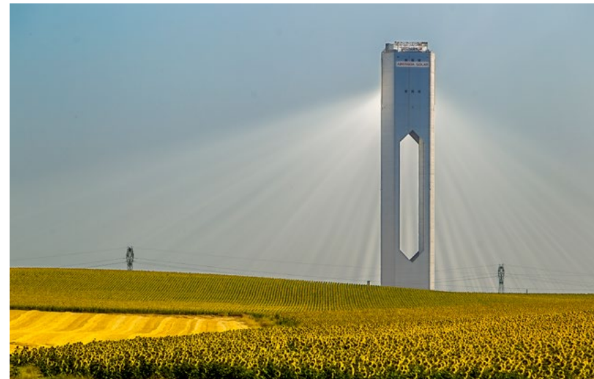
Abengoa tiene en operación y en construcción cuatro proyectos de torre
