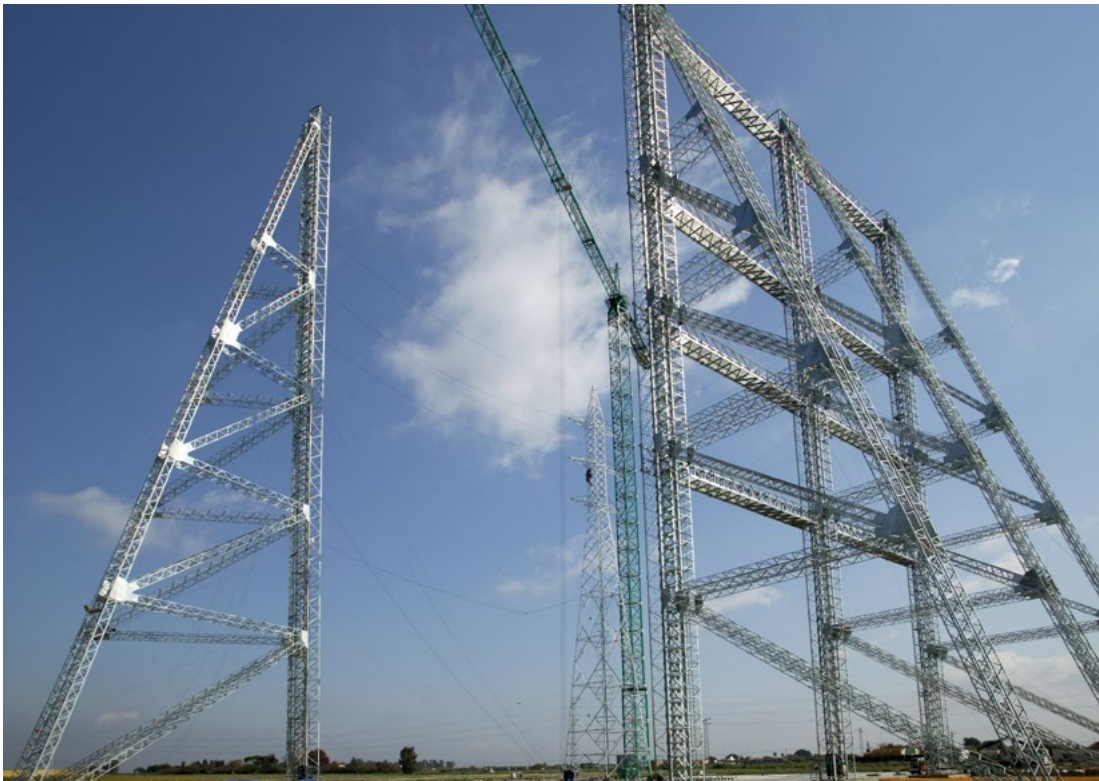
Abengoa realiza pruebas de estructuras de torre de hasta 72 metros de altura en Utrera (Sevilla)
