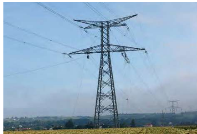
Abengoa trabaja para la operadora pública francesa responsable de los sistemas de transmisión en Francia desde hace 15 años.
