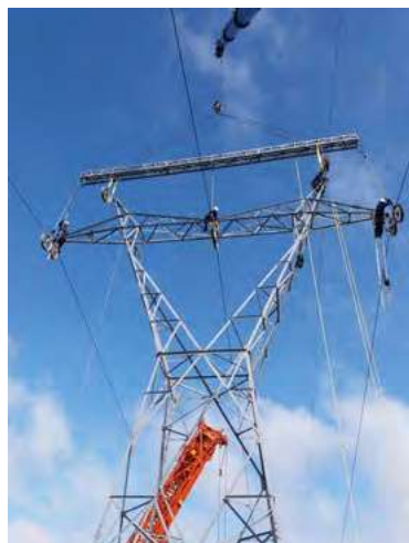
Tramos de la línea Belesar – Mesón.
