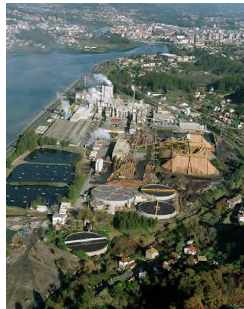
Planta de depuradora de agua industrial en Ence Pontevedra desarrollada por Abengoa.
