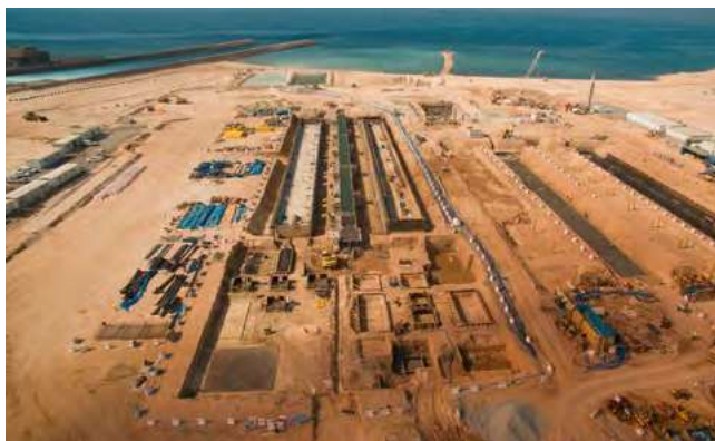
Imagen de los trabajos que Abengoa está realizando en Arabia Saudí.
