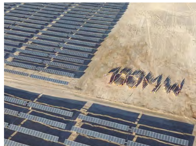
Imagen de los trabajos desarrollados en la planta fotovoltaica del complejo solar Cerro Dominador. Copyright Cerro Dominador.
