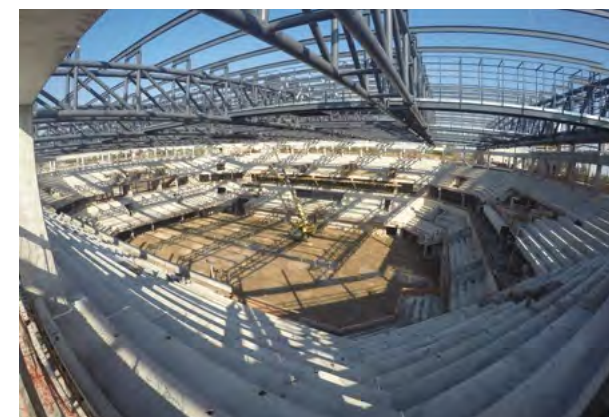
Abengoa trabaja en el nuevo complejo de espectáculos de Montevideo, el Uruguay Antel Arena.
