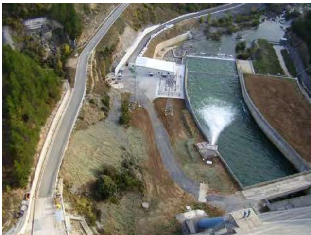
Central de pie de presa de Itoiz desarrollada por Abengoa.
