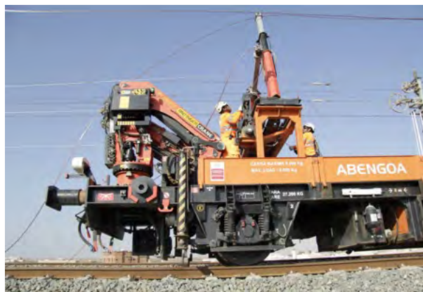
Imagen de los trabajos del proyecto Meca - Medina en Arabia Saudí.
