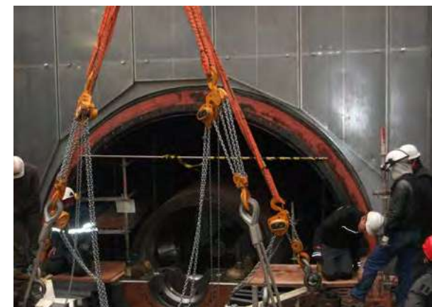
Inspección mayor en las turbinas de gas de la Planta ISCC Ain Beni Mathar (Marruecos).
