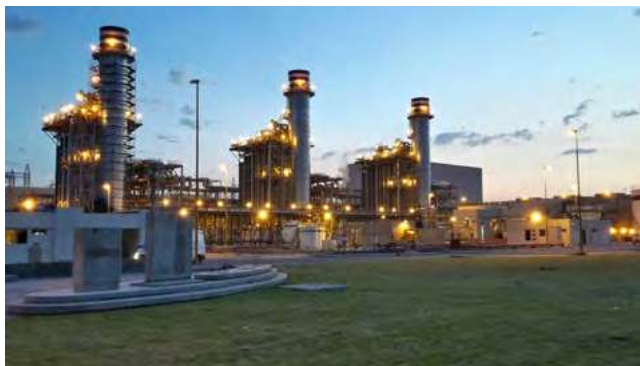
Central de ciclo combinado en Centro Morelos, México.
