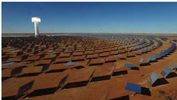
Khi Solar One cuenta con una capacidad de 50 MW y dos horas de almacenamiento.
