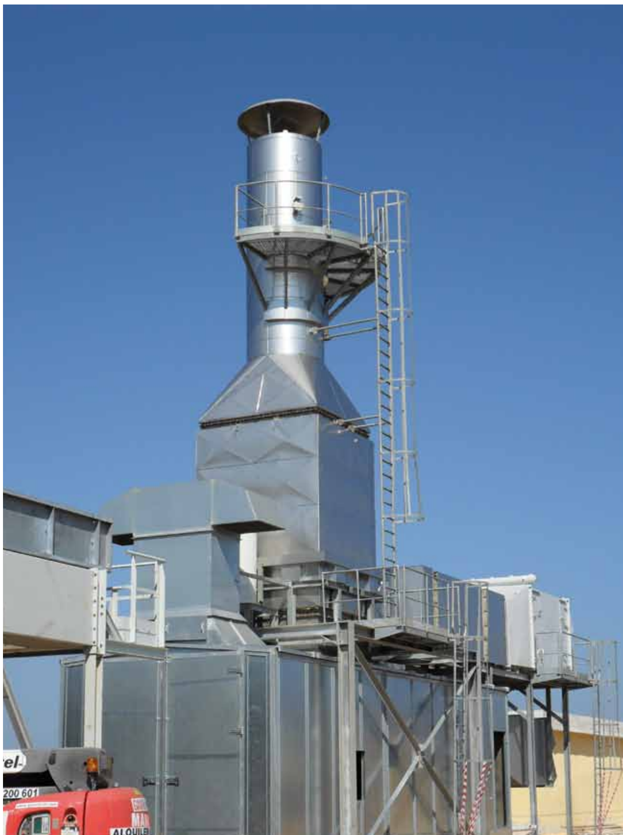
Estación de compresión de gas fabricada en acero inoxidable
