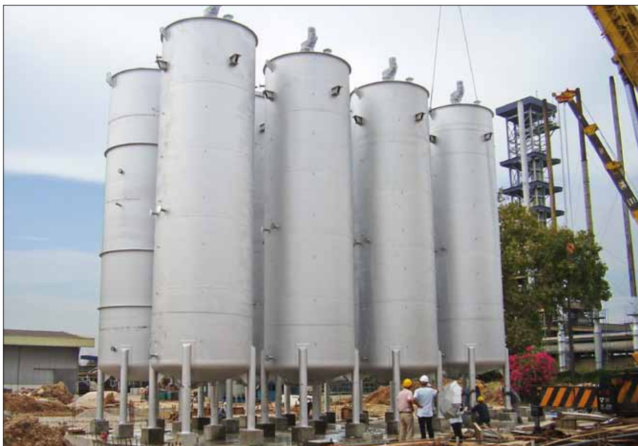
Depósitos de aceite de palma fabricados con acero inoxidable.
