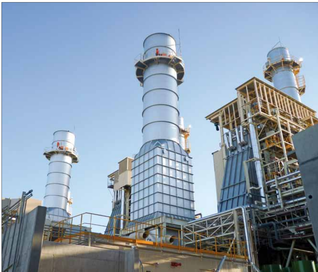
Sistema de recuperación de calor para centrales de ciclo combinado en acero inoxidable.
