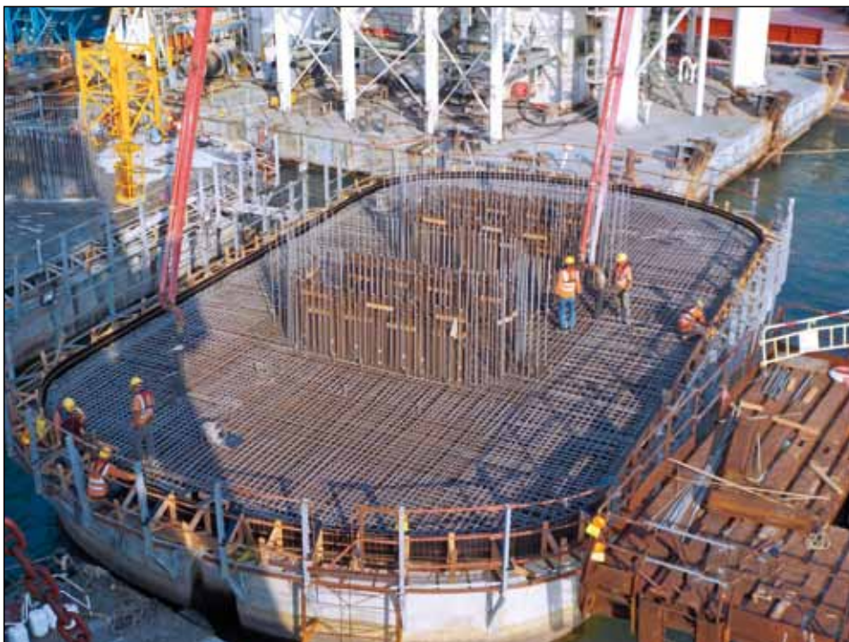
Barra corrugada de acero inoxidable en la construcción del puente Hong Kong - Zhuhai - Macao.
