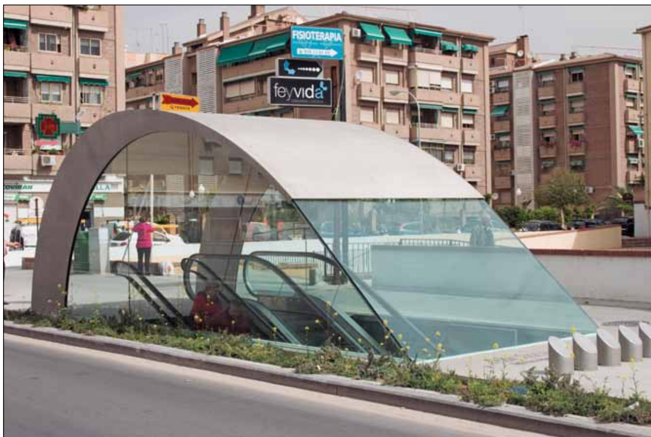
Cubierta del metro de Granada en acero inoxidable y cristal.
