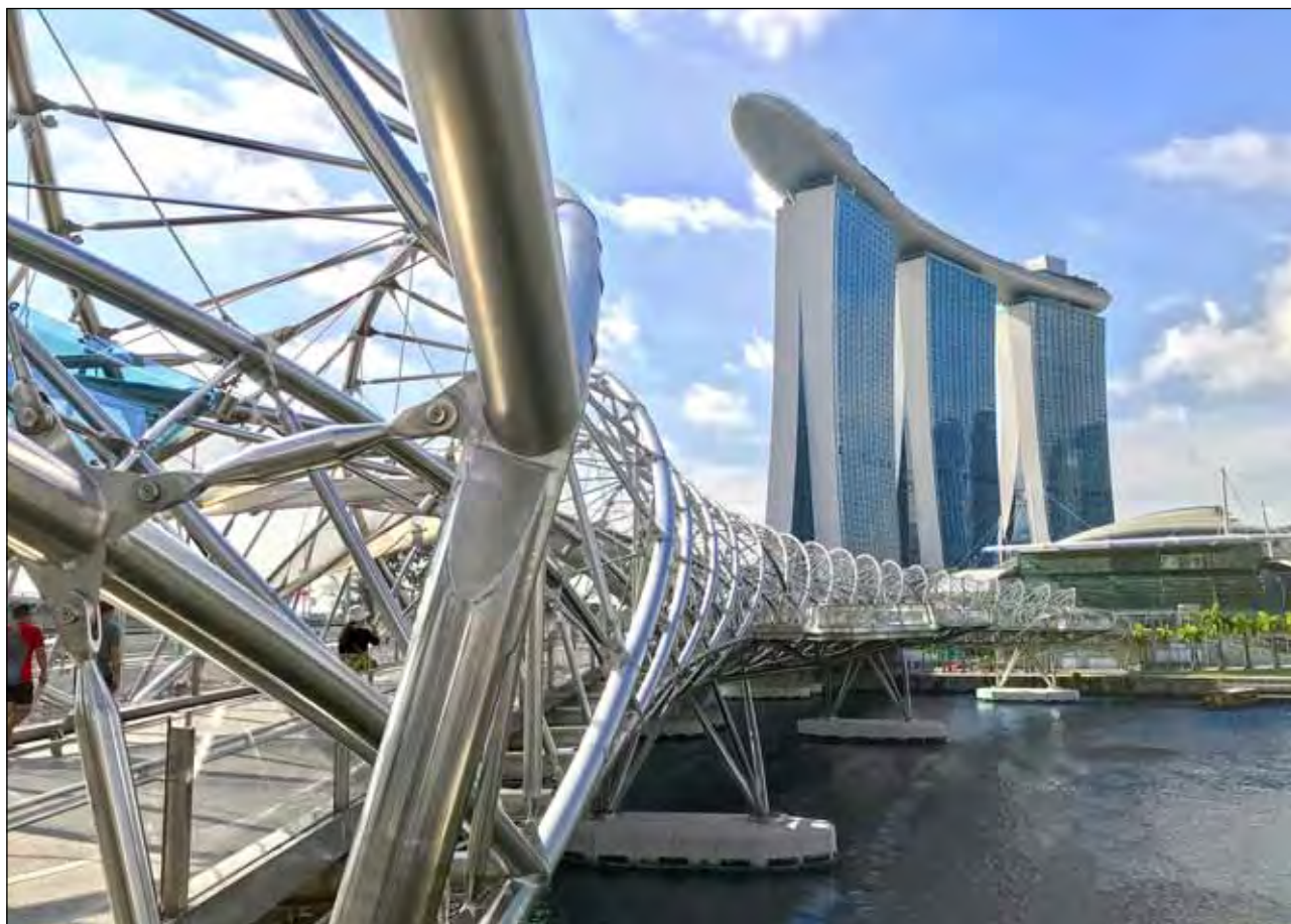
Pasarela fabricada con acero inoxidable en Singapur.
