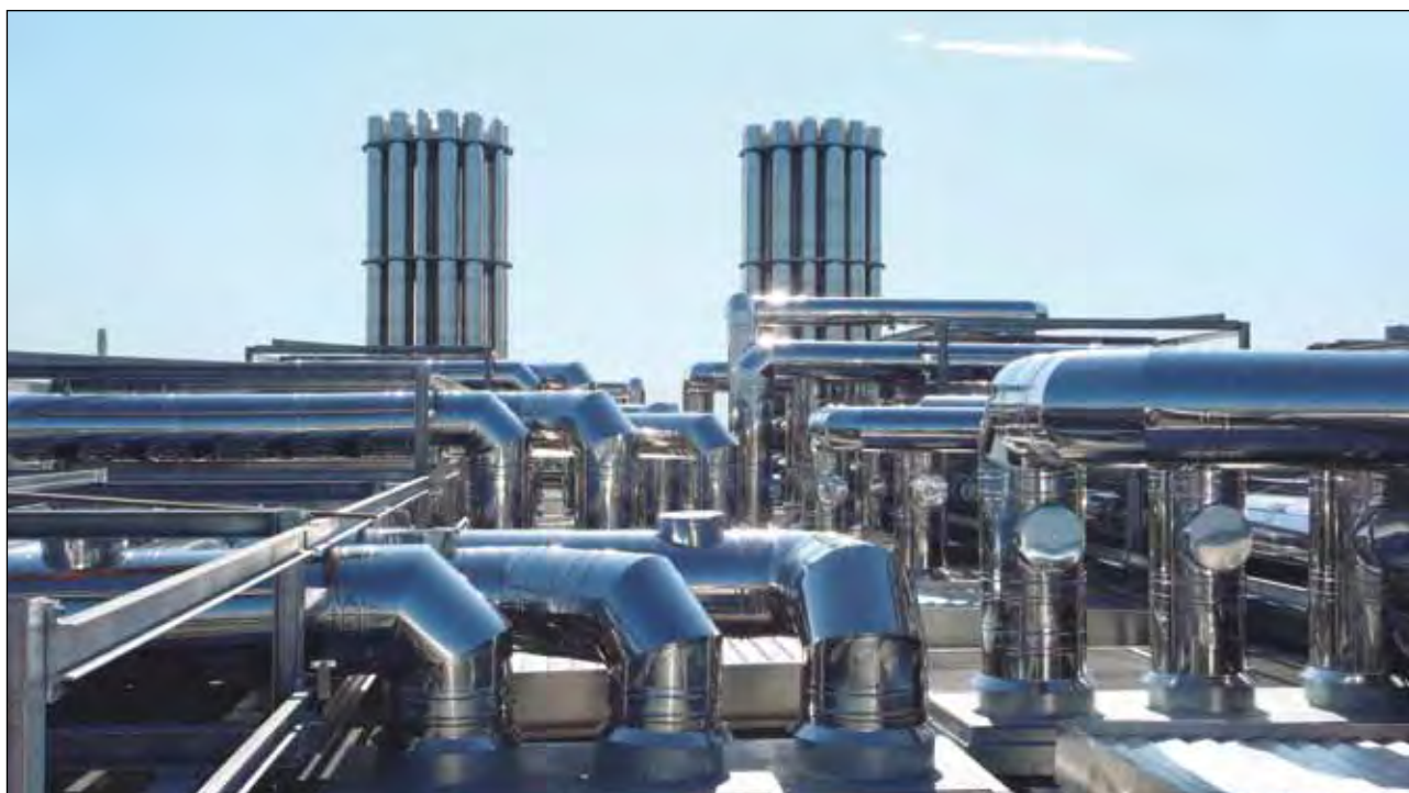
Sistema de evacuación de humos fabricado en acero inoxidable.
