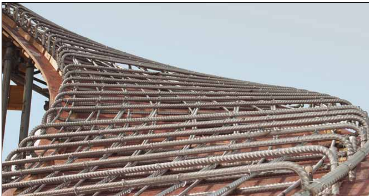
Barra corrugada de acero inoxidable en la construcción de la Sagrada Familia.
