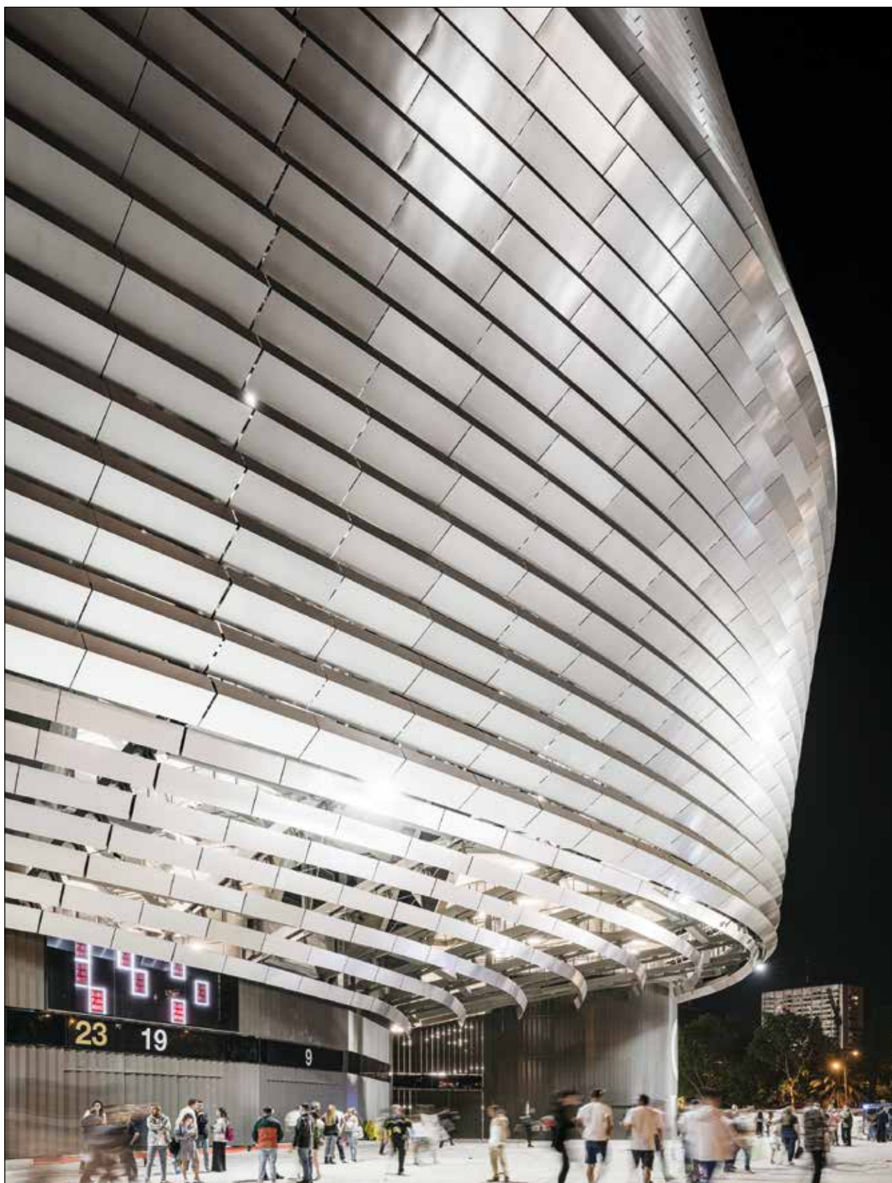
Estadio Santiago Bernabeu con revestimiento de acero inoxidable fabricado en España
