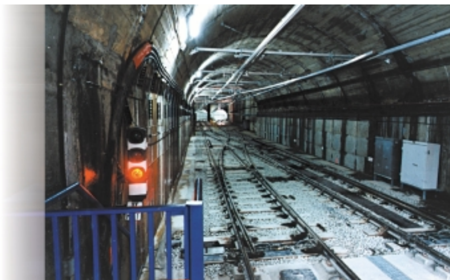
▲ Distribución de energía y catenaria rígida. Metro de Madrid
