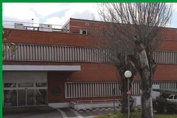
PLANTA DE INYECTABLES
