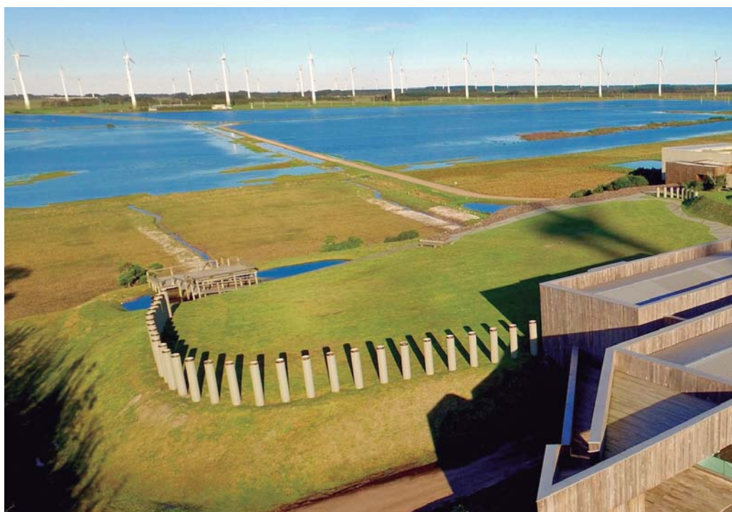
Complejo eólico Osório (Brasil). Enerfín
