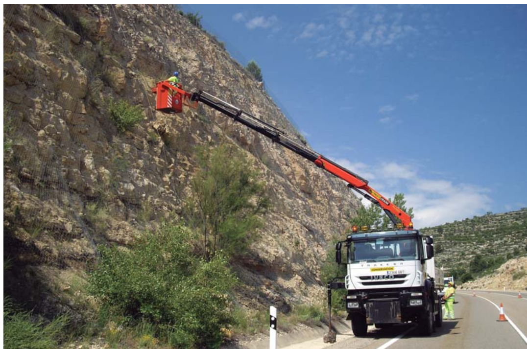
Actuaciones en malla de protección de taludes. Audeca
