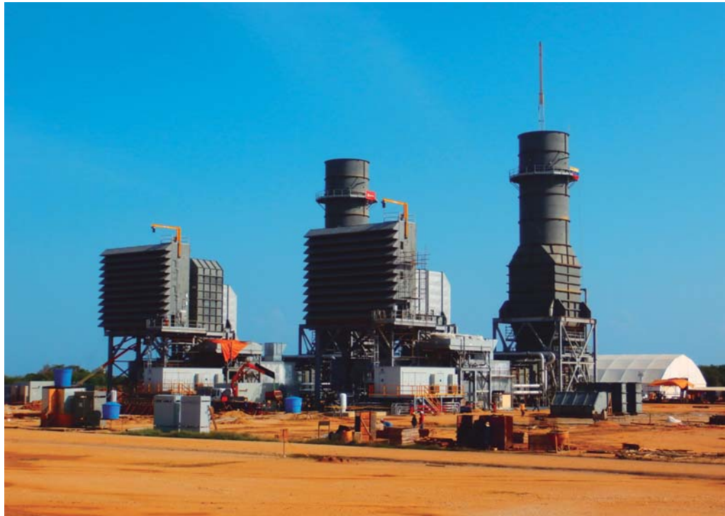
Instalaciones de aguas en la Central Térmica de Güiria (Venezuela)
