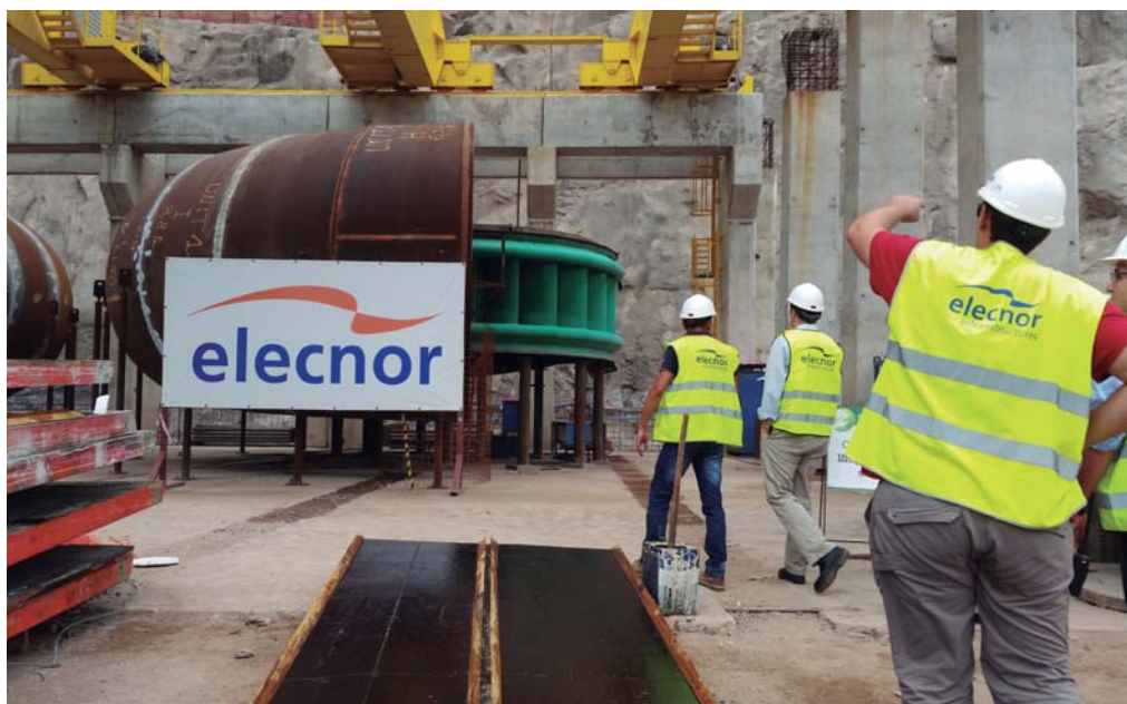
Central Hidroeléctrica Cambambe 2 (Angola)
