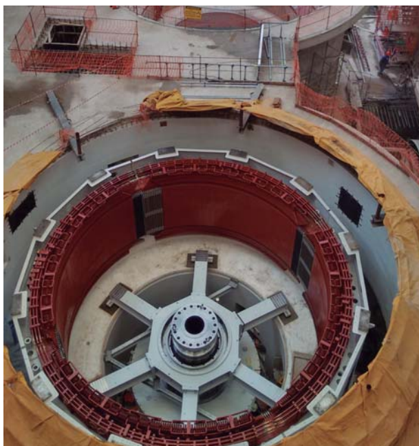
Central Hidroeléctrica Cambambe 2 (Angola)
