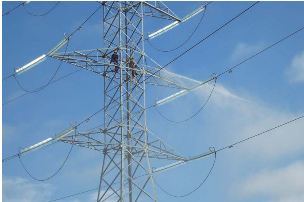
Lavado de aisladores con agua desionizada
