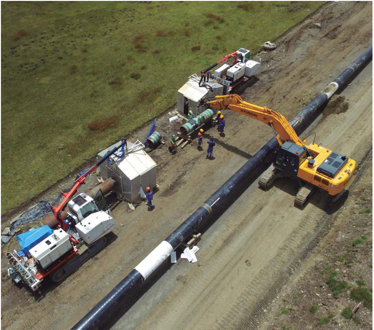
Gasoducto Sur Peruano
