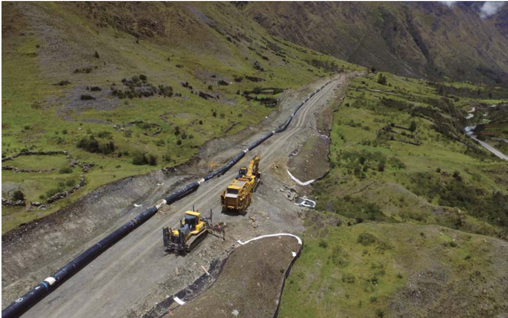
Gasoducto Sur Peruano
