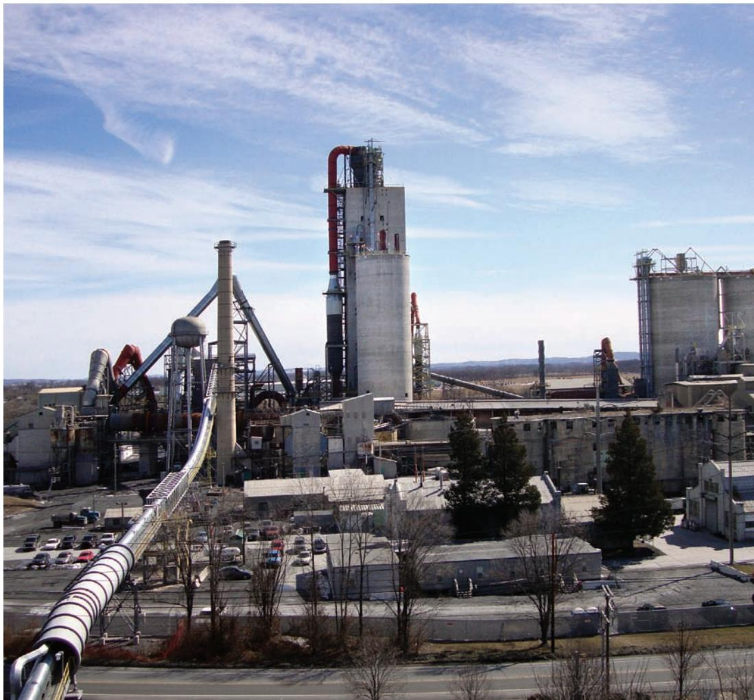
Asimismo, en 2009, se ha concluido la construcción de dos silos cilíndricos de clinker y una tolva en la fábrica de Harleyville, Carolina del Sur, cumpliendo así con las normas medioambientales. Esta obra por importe de 13,0 millones de dólares, permitirá ampliar la capacidad de almacenamiento y facilitar la producción de distintas calidades de clinker, y por tanto de mayor variedad de cementos de diversas aplicaciones.
