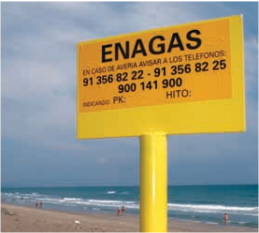
Señalización del trazado del gasoducto
