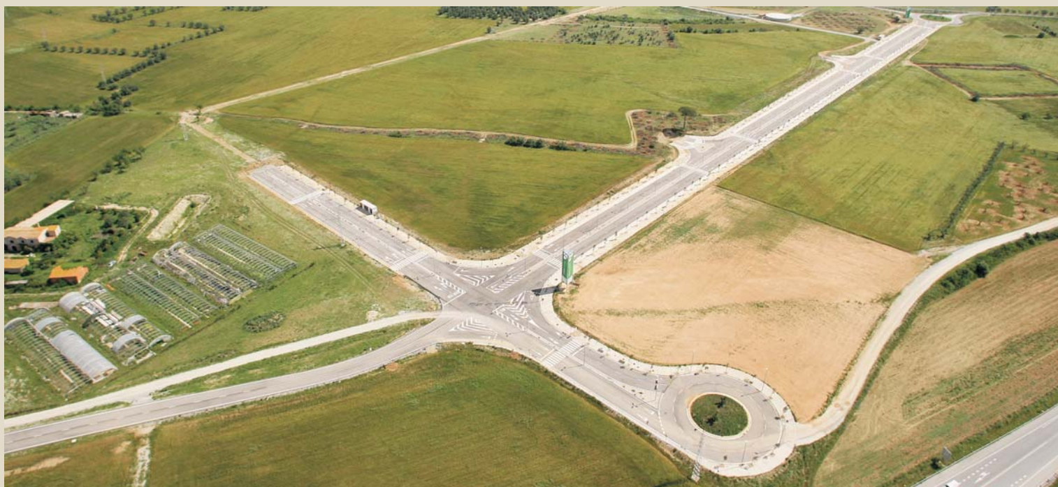
LOGIS Empordà, obres d'urbanització
