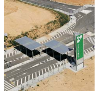
Barrera d'accés a la CIM. Port de Tarragona
