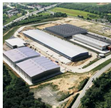
Instal·lacions de la CIM la Selva
