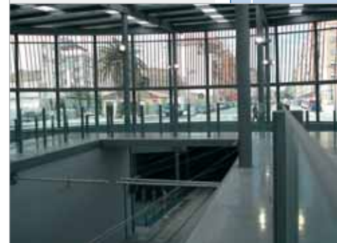
Estación de Serrería Metro de Valencia
