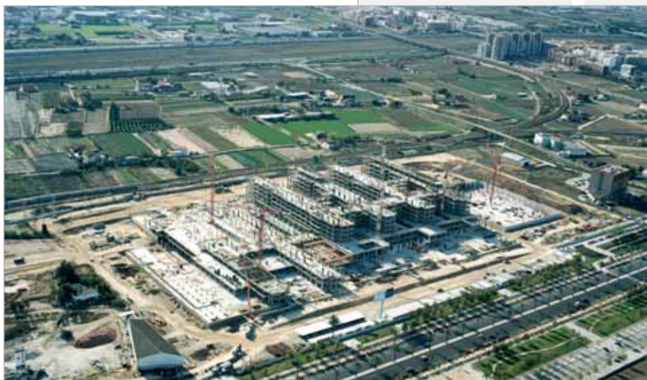
Nuevo hospital La Fe en Valencia
