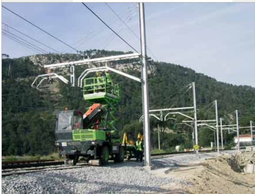
Trabajos en catenaria
