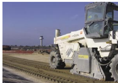
Estabilización de suelos. El Prat del Llobregat.
