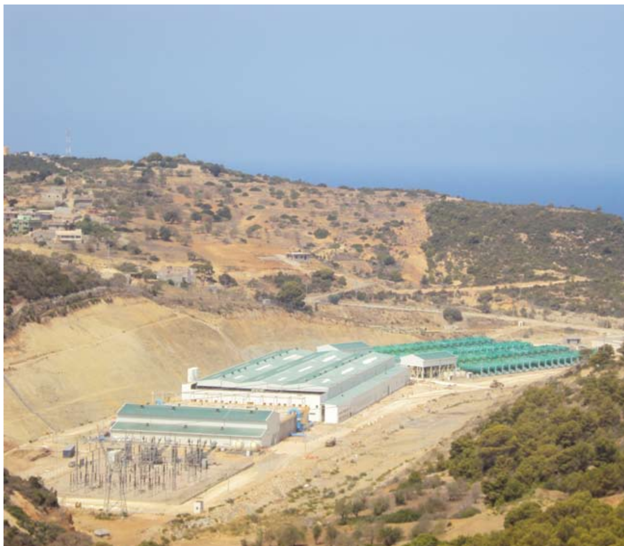
> Planta desaladora en Hounaine. Argelia
