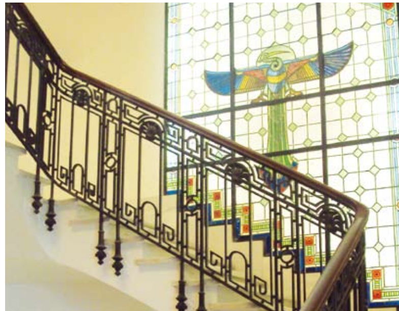
> Rehabilitación edificio Gran Vía, 4. Madrid
