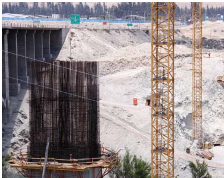
> Trabajos de construcción Autopista ValLENAR – Caldera. Chile
