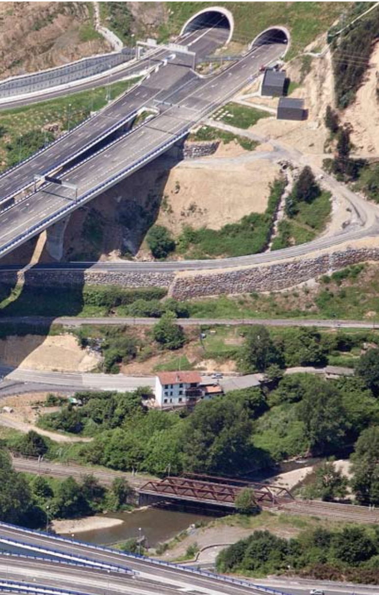
> A-8 Bilbao, enlace Cadagua. Vizcaya
