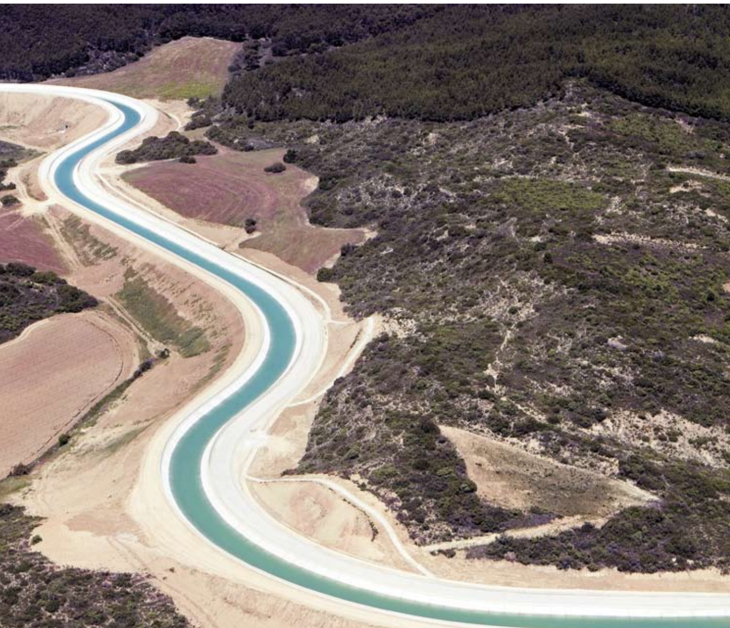
> Tramo 7B. Canal de Navarra
