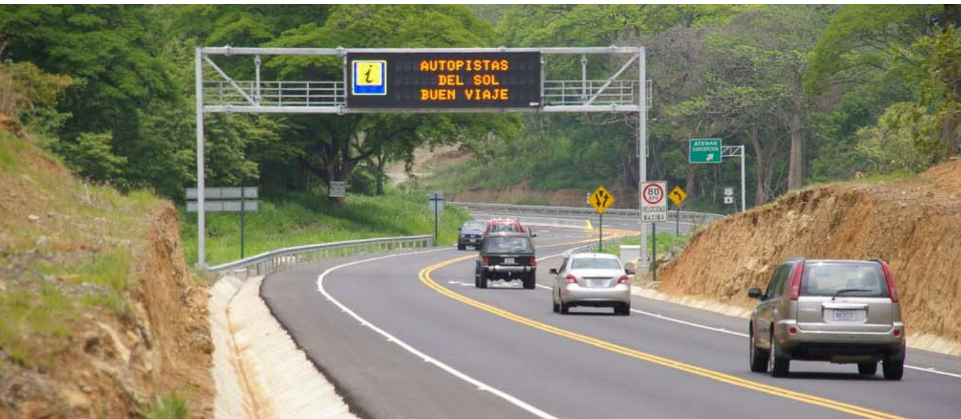
> Autopistas del Sol. Costa Rica
