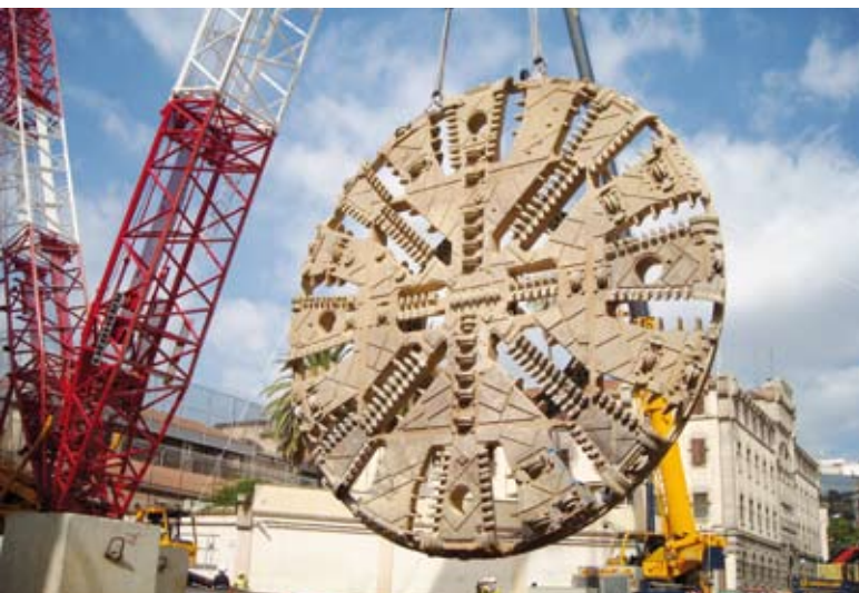
> Montaje tuneladora. UTE La Sagrera. Barcelona
