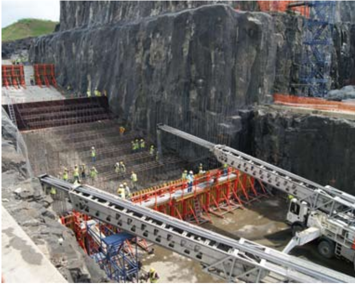
> Construcción tercera esclusa del Canal de Panamá
