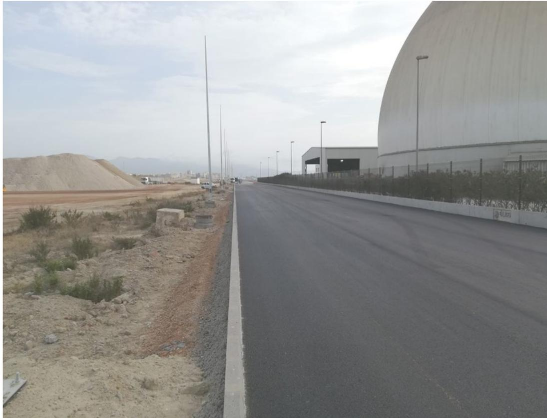
Consiste en la formación de la explanada, así como de una base compuesta por 25 cm de zahorra artificial extendida y compactada sobre 30 cm de suelo seleccionado, pavimentación con mezcla bituminosa en caliente compuesta por una base de 16 cm G-25, una capa intermedia de 10 cm de G-20 y una capa de rodadura de 4 cm de D-12, y la realización de las obras de drenaje, abastecimiento, red contraincendios alumbrado y comunicaciones.
