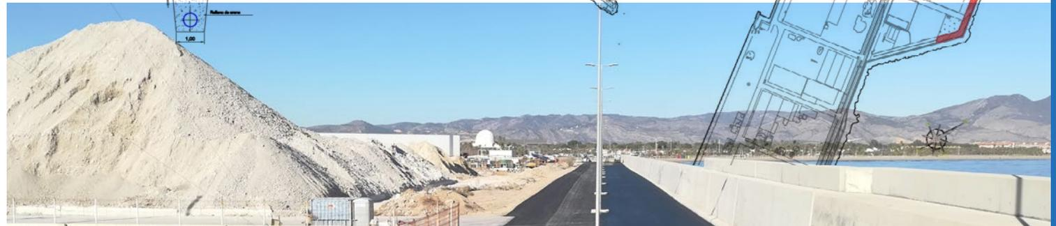
Las obras proyectadas consisten en la ejecución de un vial de 450 m de longitud y 15 m de ancho con una calzada por sentido de 4 m y una zona de aparcamiento de 2,75 m por sentido, separadas por una mediana de 1,5 m en la que se ejecuta el drenaje las comunicaciones y alumbrado.
