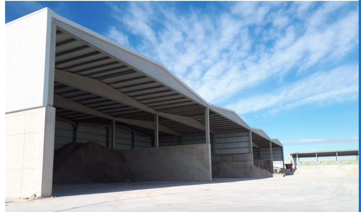
La obra consiste en la ejecución de 3 boxes con 3 muros de hormigón armado HA-30/B/20/IIIa+Qb de 0,8 m de anchura y 6,5 m de altura sobre zapatas conformando una U sobre la que se ejecuta la solera de hormigón resistente a flexotracción HF-4'5/B/20/IIIa+Qb MR SR de 25 cm de espesor sobre 25 cm de base de zahorra artificial, dando lugar a una superficie de 8.510 m<sup>2</sup> con los servicios y drenaje pertinentes para la operativa.
