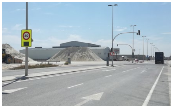
PortCastelló instala semáforos en la Dársena Norte
