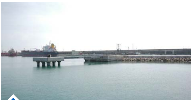
PortCastelló receptiona las obras del nuevo muelle público de graneles líquidos
