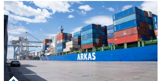
PortCastelló avanza en el suministro de electricidad a buques atracados
