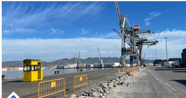
Instalación red contra incendios dársena norte
