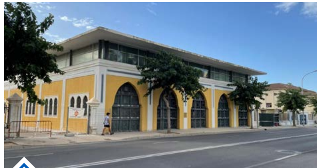
PortCastelló ejecuta dos nuevos accesos por la Avenida Ferrandis Salvador
