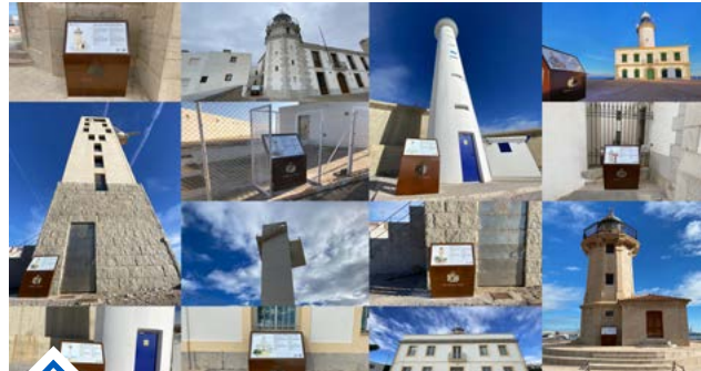
PortCastelló instala paneles informativos en sus faros
