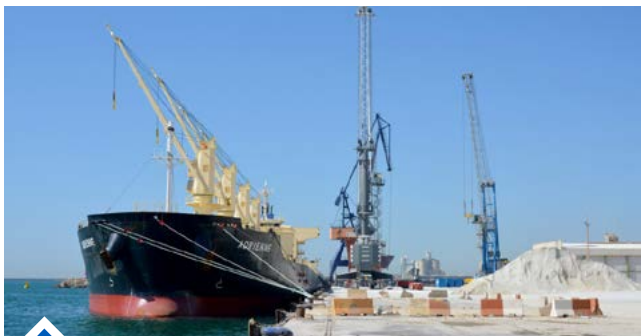
Luz verde al acondicionamiento del muelle transversal exterior
