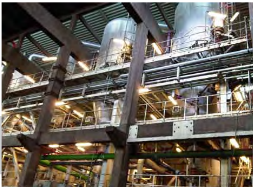
Evaporadores en planta de escorias salinas de Befesa Salzschlacke en Lünen (Alemania)
