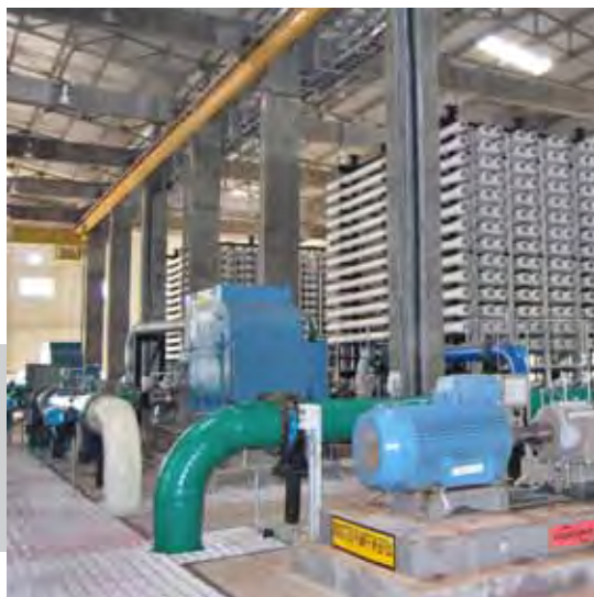
Bastidor de membranas y equipos de la desaladora Chennai (India)
