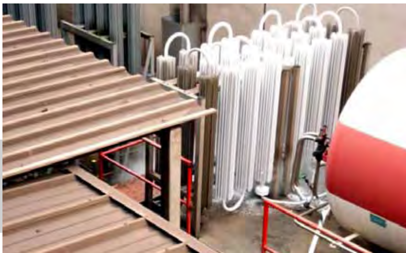
Unidad de evaporación de oxígeno líquido
