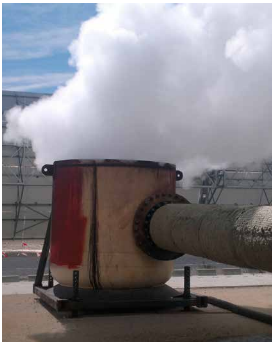
Proceso de soplado con vapor en instalación de cliente.
