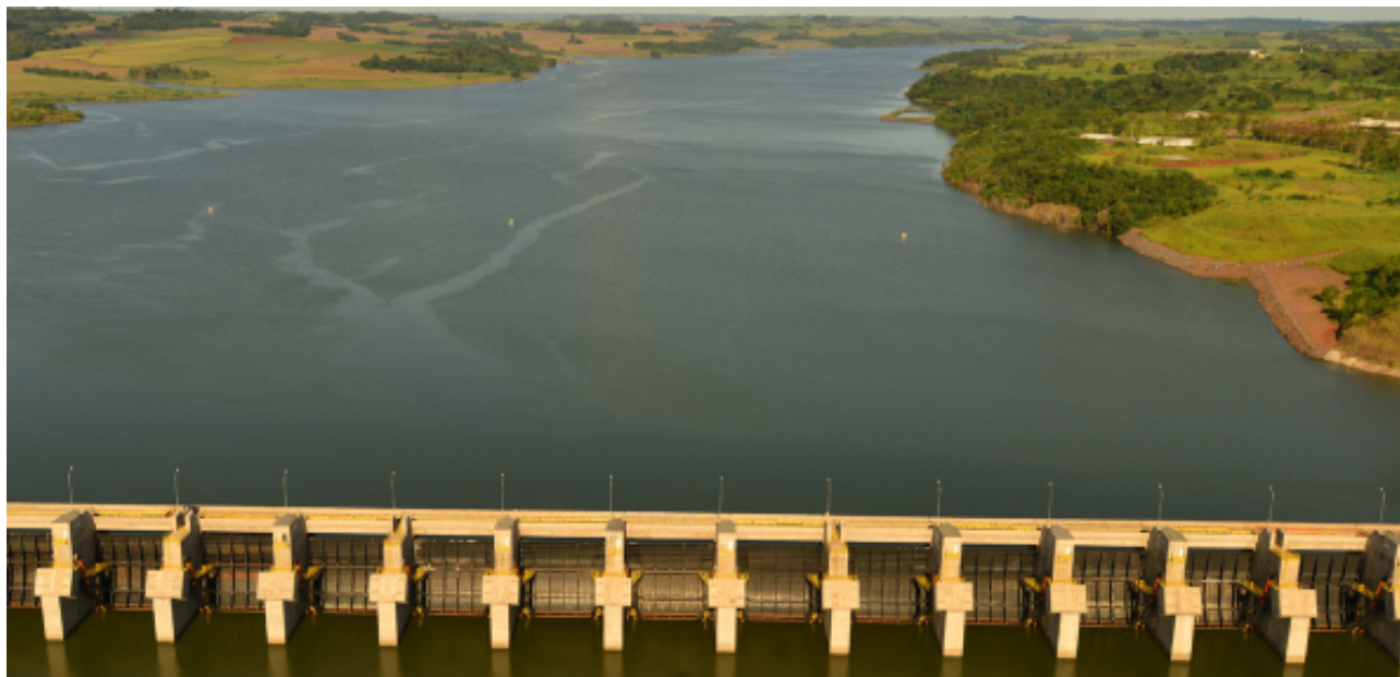
Central hidroeléctrica de Baixo Iguaçu - Paraná, Brasil
