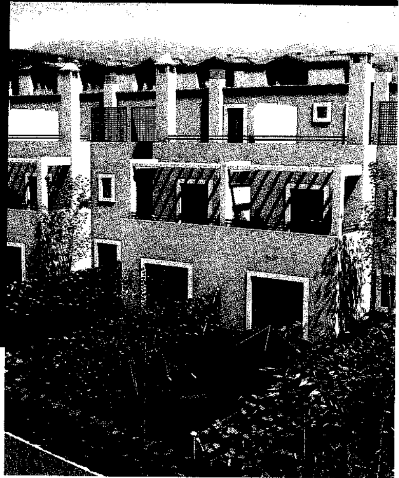
RESIDENCIAL LAS FUENTES DE SAN BERNABÉ (ALGECIRAS)
