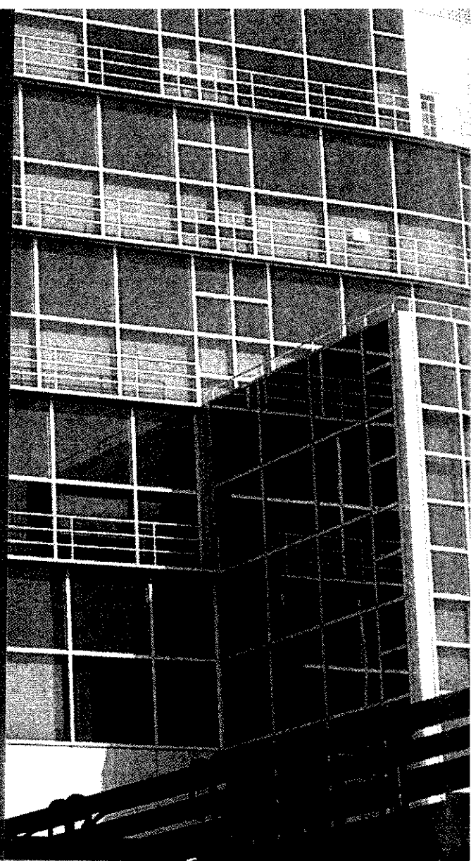
EDIFICIO SOLLUBE (MADRID) EDIFICIO CADAGUA (MADRID)
