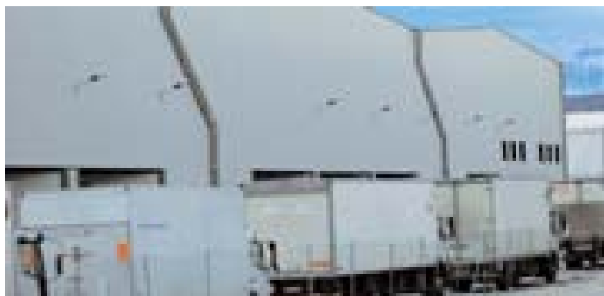
Nave industrial en Azuqueca de Henares, Guadalajara
