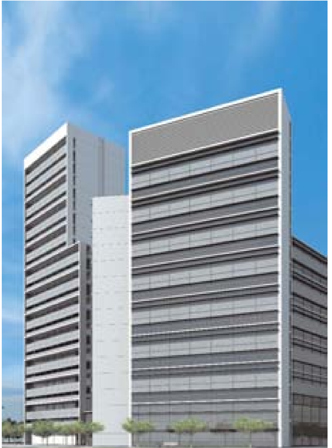
Proyecto Hotel Barceló Diagonal 0, Barcelona
