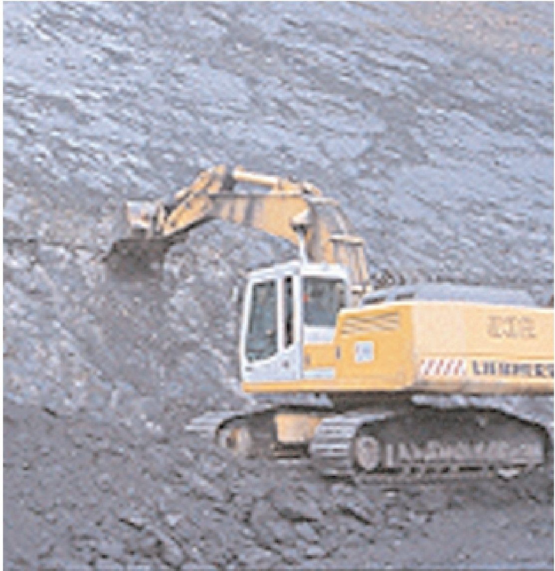
Cielo abierto. Limpieza de capa de carbón.
