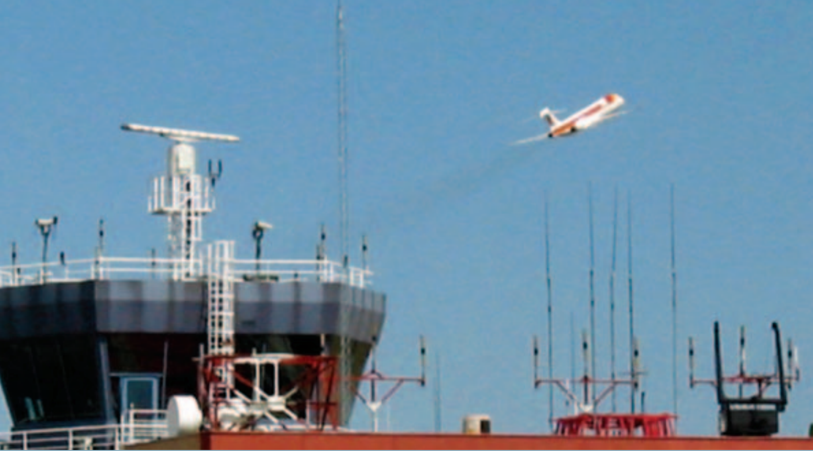
Madrid-Barajas. Torre de Control Sur. Radar de superficie
