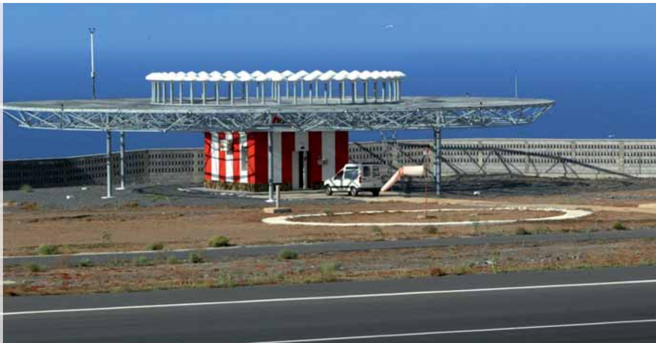
Antena VOR en el Aeropuerto de La Gomera.
