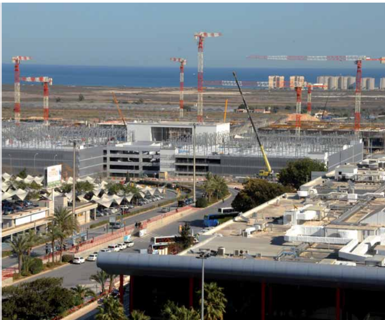
El Aeropuerto de Alicante contará con una Nueva Área Terminal.
