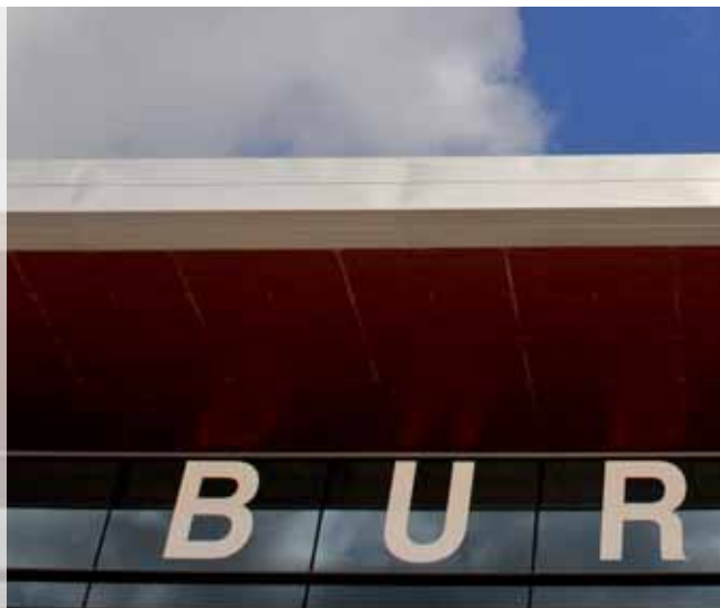
Detalle de la Terminal del Aeropuerto de Burgos.
