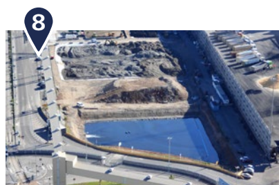
8 REPARACIÓ DEL SUBSÒL DEL MOLL CONTRADIC. FASE 2
