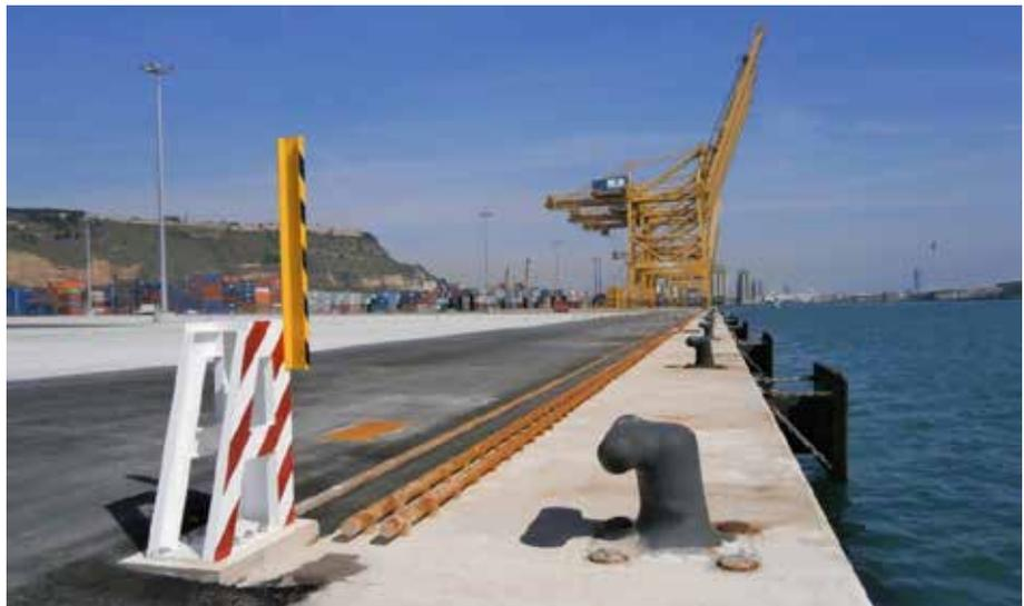
El proyecto contempla los trabajos necesarios para dejar acabada la ampliación del muelle Sud de la Terminal de Contenedores de Barcelona (TCB) para su uso por parte de esta empresa. Para ello se ha instalado el carril lado tierra, quedando por ejecutar los *tie-down* y los *anchor-pin*, elementos protectores del cable de las grúas. La obra comprende
