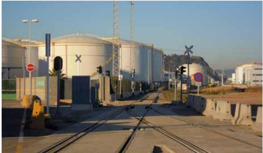
La adaptación de las instalaciones ferroviarias del Port a la circulación de composiciones en ancho internacional es una actuación prioritaria para la APB. La terminal del muelle de la Energía ya disponía de un tercer hilo en sus alineaciones principales, colocado en previsión de una adaptación futura. Esta obra prevé la adaptación del tramo de acceso hasta conectarlo con la alineación
