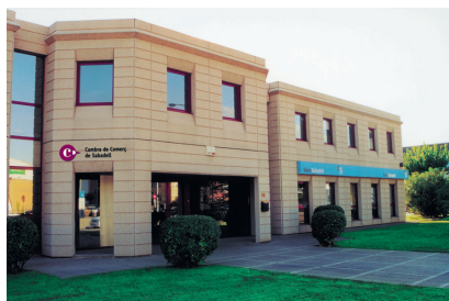
Oficina de serveis de Montcada i Reixac
