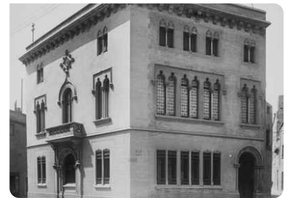
Antigua sede de Caixa Terrassa
