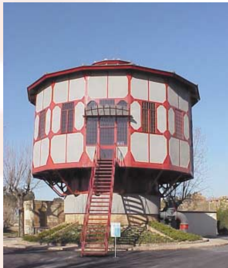
Rehabilitación pozo Fives Lille
