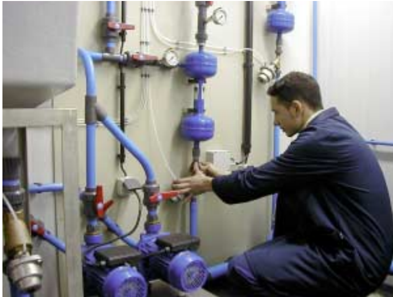
Montaje de una estación de control de calidad de aguas. Adasa Sistemas
