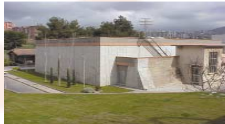
Nuevo depósito Relleu. Sant Joan Despí. (Barcelona)
