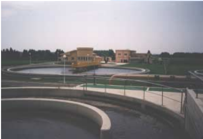
Depuradora de Torroella de Montgrí. Aquaplan.
