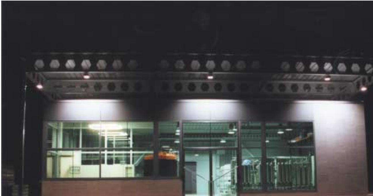
Planta de tratamiento de lixiviados mediante ósmosis inversa. Sta. María de Palautordera (Barcelona)
