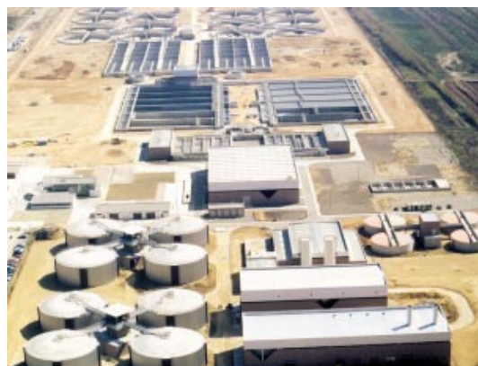
EDAR del Baix Llobregat
