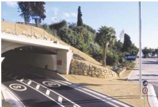
Túnel de Miramar a Montjuïc
