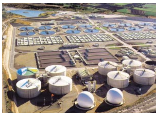
EDAR de la Farfana gestionada por Aguas Andinas en Chile
