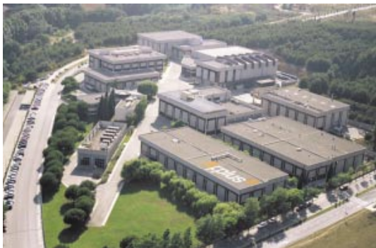
Vista aérea de las instalaciones de Applus+ CTC
