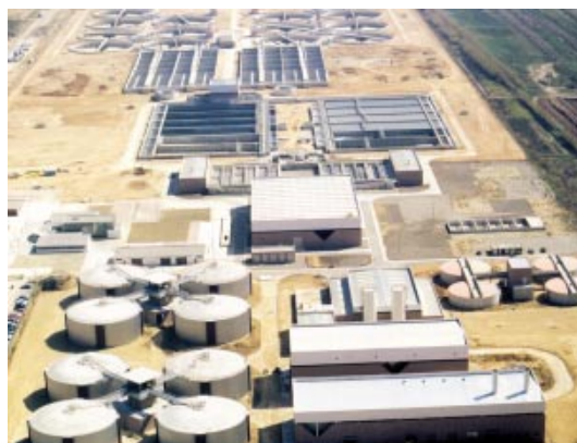
EDAR del Baix Llobregat
